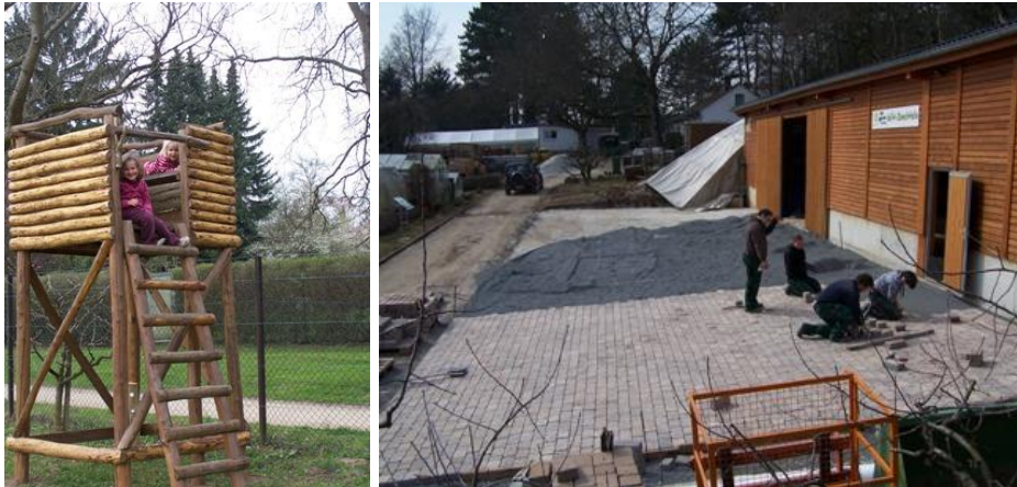
Abb. 68: Im Rahmen der Umgestaltung des Gartengeländes am Lohrberg wurde eine Aussichtsplattform errichtet und der Platz vor der Maschinehalle gepflastert.
