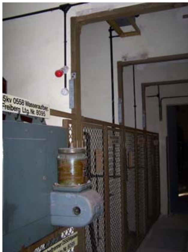
Rückseite 10 kV- u. 15 kV-Anlage
