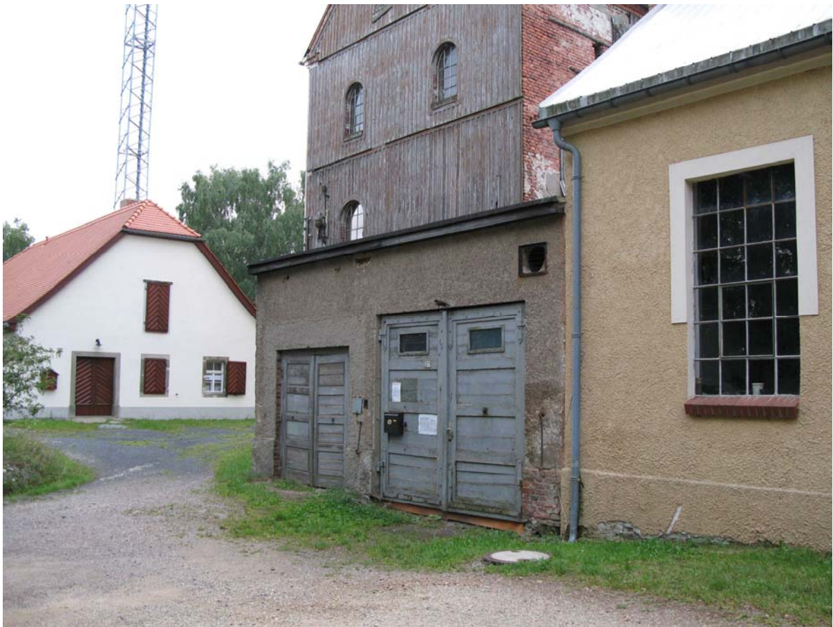
Zustand vor Projektbeginn
