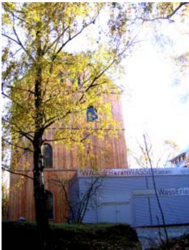
Frontansicht Neubau u. Hängebank
