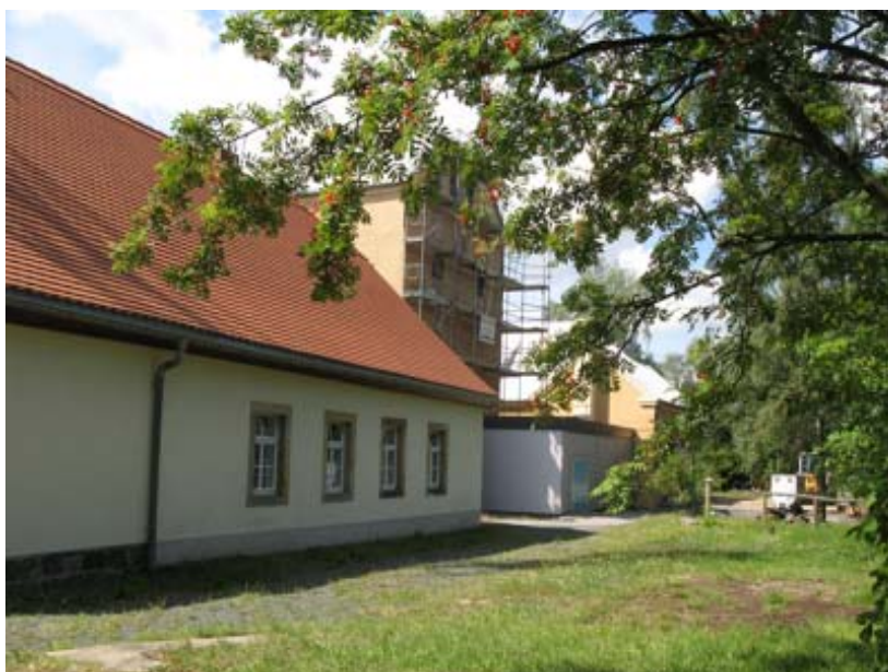
Blick von der Scheidebank zum Ensemble Neubau / Hängebank / Maschinenhaus
