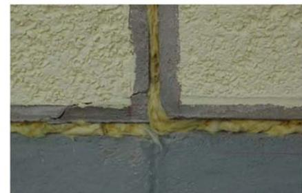
Abb. 6: Fugensanierung - Erfüllung der Anforderungen gemäß Energieeinsparverordnung (EnEV)
