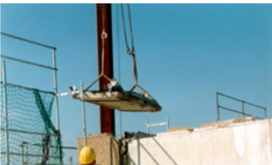
Abb. 29: Hebebänder bei der Deckendemontage
