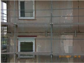
Sicherungsmaßnahmen über neue Ringankersysteme - stabilisieren die neuen Außenwandbereiche,
