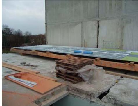
Abb. 2: Teil des Notdaches und Abdeckung sonstiger Deckenöffnungen
