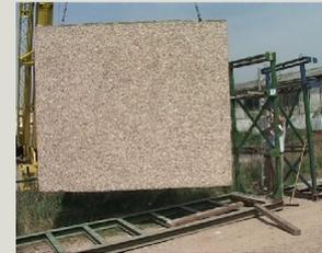
die Fertigteile konnten nach vollständiger Sortimentierung - und Überprüfung durch den zuständigen Statiker, während Demontagepausen in bereitgestellte Innenladeraupletten verstaub und unabhängig von der Bautätigkeit auf der Baustelle, durch eine Spedition abtransportiert werden,
