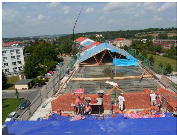
Abb. 18: Erstellen einer neuen Dachgiebelwand
