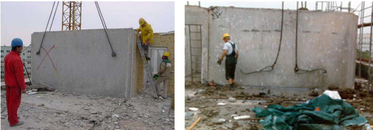
Abb. 27, 28: Durchstecksystem, 4-Strang-Kettengehänge
