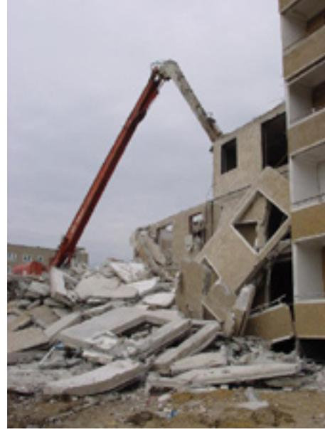
*Abb. 13, 14: Abbruch von Plattenbauten in Weißwasser*
