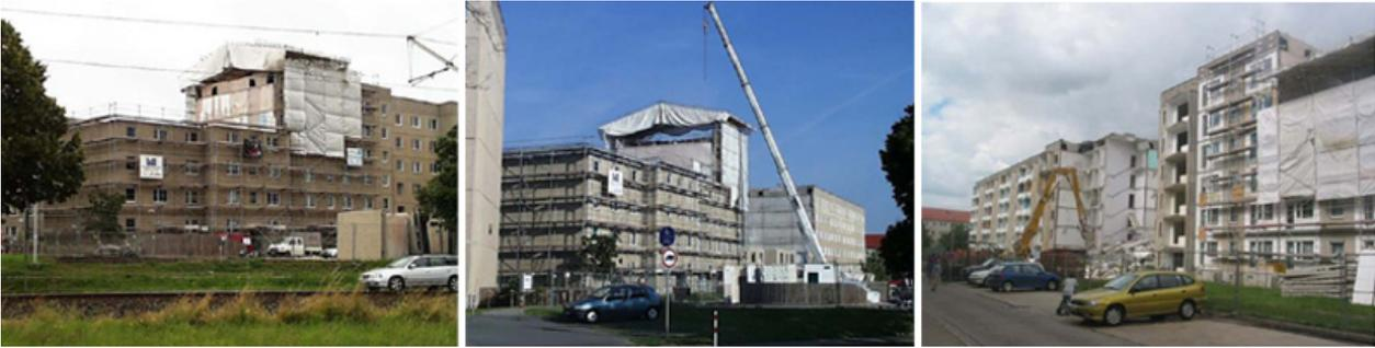
Abb. 2: Rückbau der Randsegmente und Abruch des Mittelsegments
