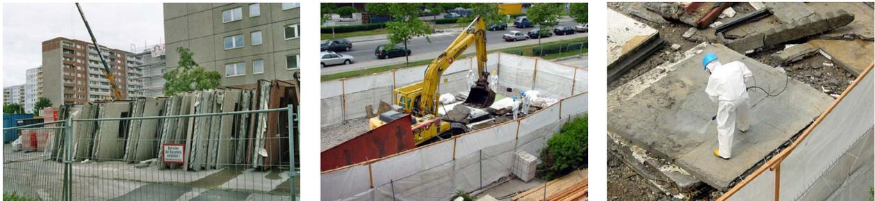
Abb. 39 - 41: Selektion von künstlichen Mineralfasern (KMF) aus Außenwänden im eingehausten Bereich auf der Baustelle Berlin-Marzahn „Ahrensfelder Terrassen“
