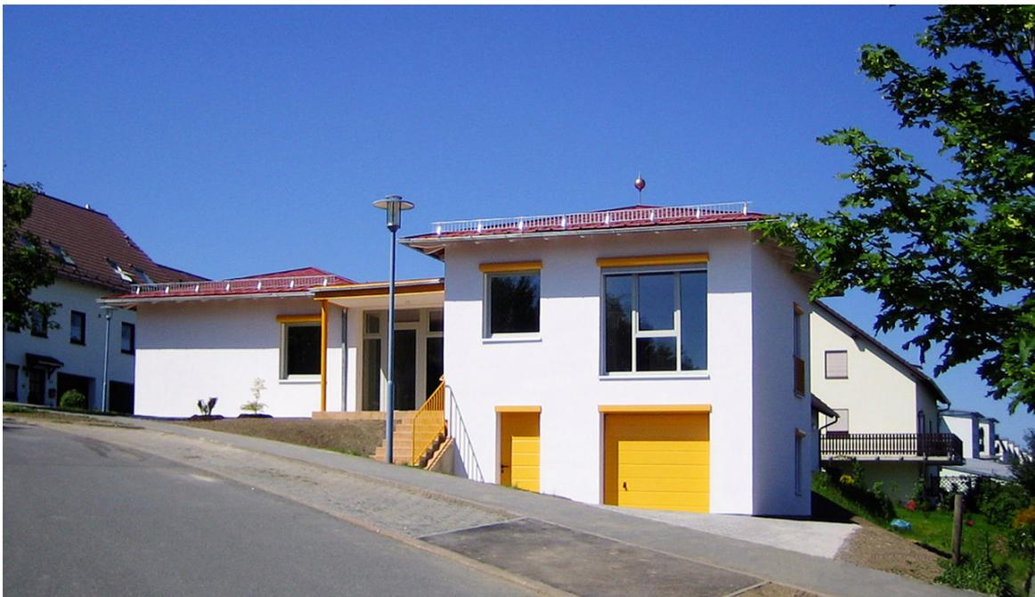
*Abb. 8: Wiederverwendung abgetragener Betonelemente zum Einfamilienhaus am Hang in Plauen*
