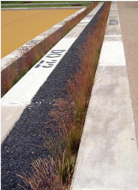
Abb. 4: Lange Treppe mit aufgesprühter alter Bauteilbezeichnung als „Label“ der neuen Einbauten
