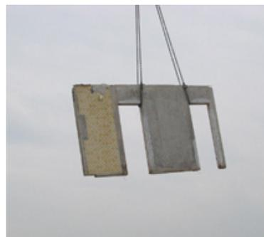
Abb. 30: 2-Strang-Kettengehänge bei der Wanddemontage
