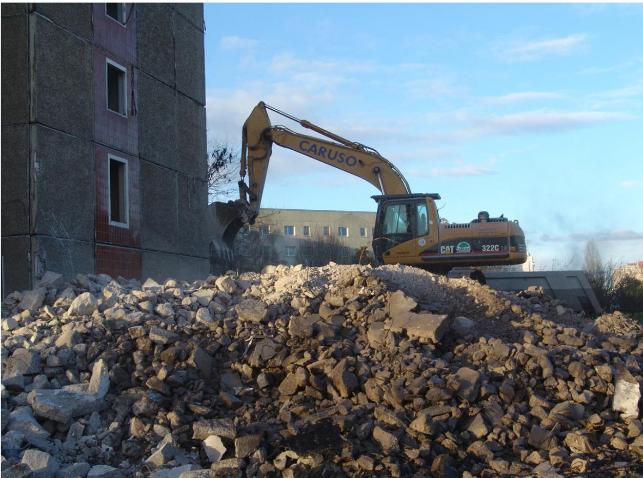
Abb. 2: Der notwendige Rückbau ist vielfach ein Abriss, der mit der Zerkleinerung von Plattenbauten endet
