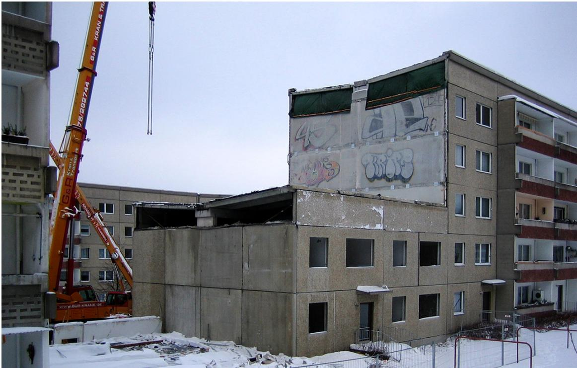
Abb. 3: Versuchsanordnung zum Wiedereinbau des Daches
