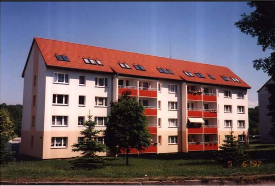
Abb. 2: Blockbau nach Komplettsanierung mit Dachausbau
