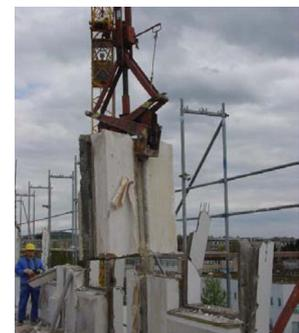
Abb. 31: Zange bei der Wanddemontage (Blockbauweise)
