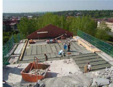
Abb. 3: Aufbringen der Bitumendampfsperre
