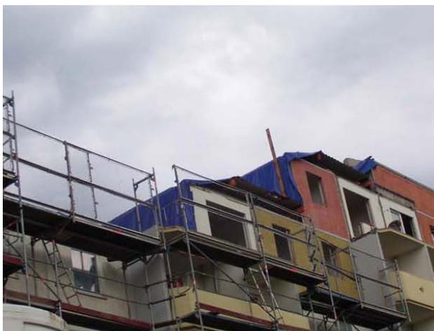
Abb. 17: Notabdichtung in der Ausführungsphase
