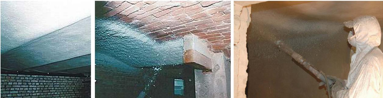
Abb. 9: Beispiel Kellerdeckendämmung im Spritzverfahren
