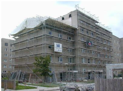
*Abb. 1: Einrüsten der Fassade und Durchfeuchtungsschutz der Dachzone*
