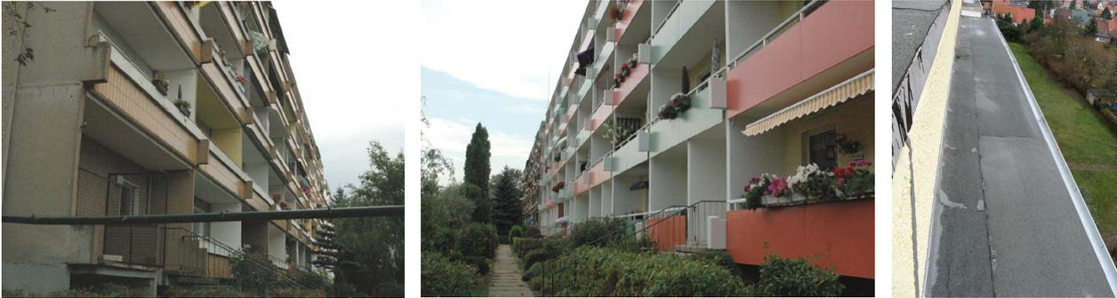
Abb. 8: Beispiel Balkone vor und nach der Sanierung, Rinnenentwässerung Balkondach
