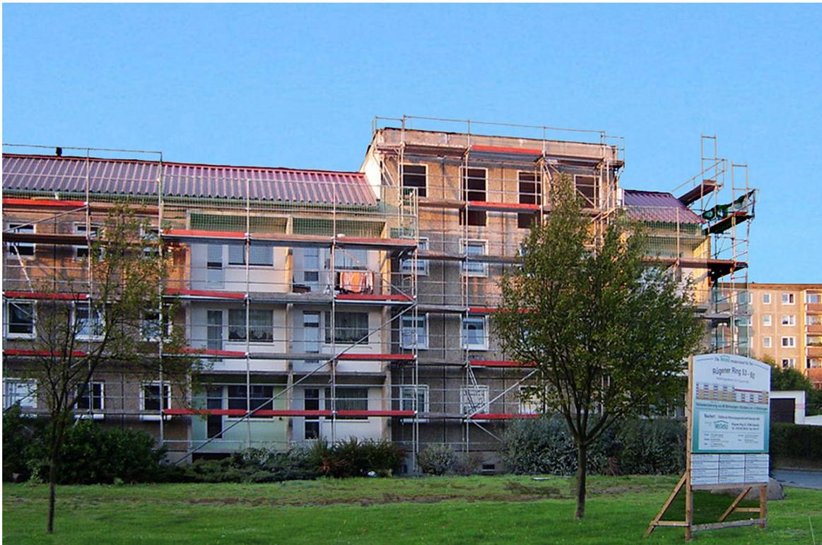
Abb. 7: Geschoßabtrag mit differenzierten oberen Gebäudeabschluß. Sassnitz
