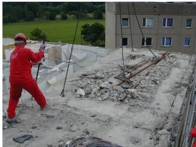
*Abb. 2: Lösen und Anheben einer Deckenplatte*
