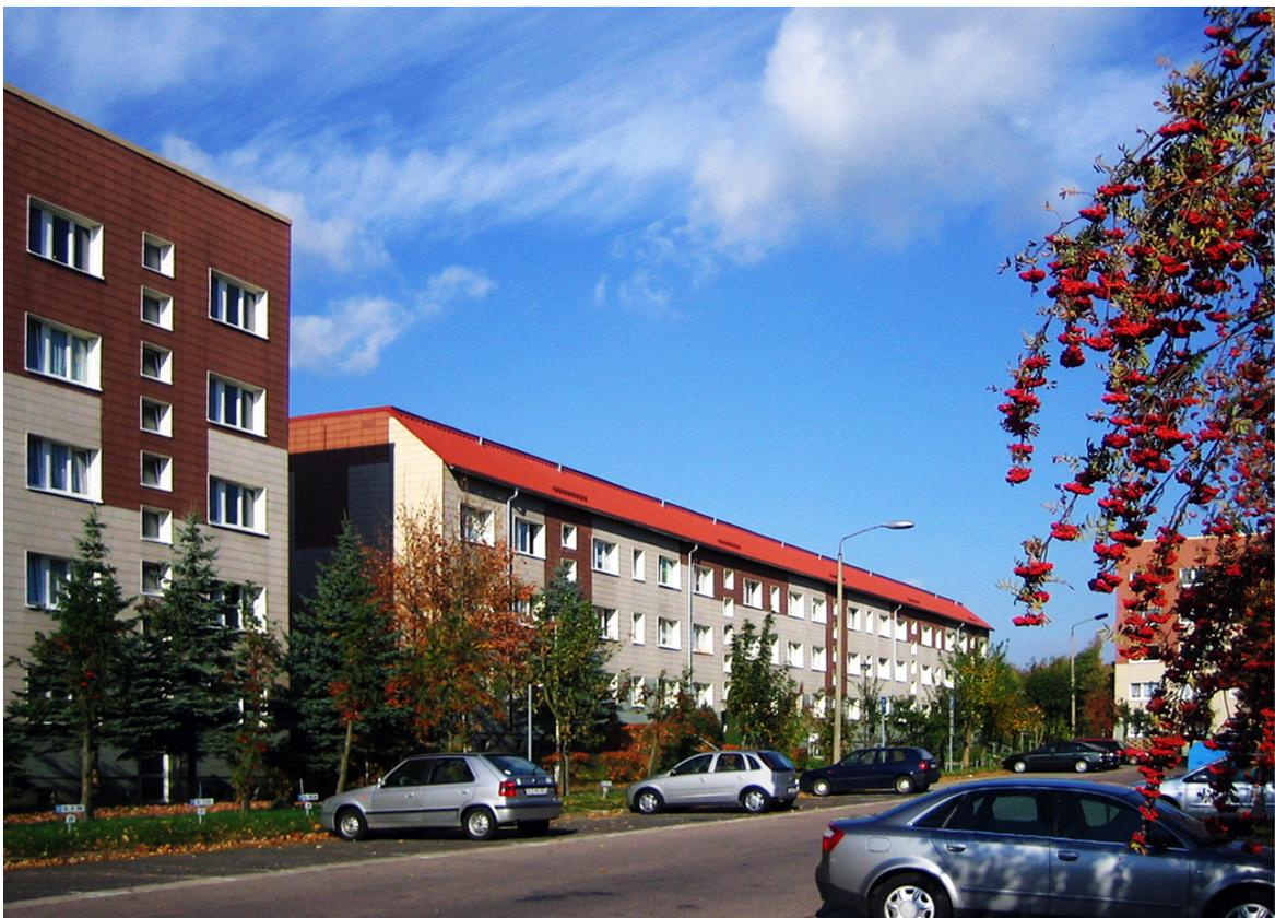
*Abb.6: Geschoßabtrag unter bewohnten Bedingungen mit Einbau Steildach. Hartha*
