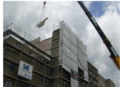
*Abb. 3: Ausbau von Betonteilen*
