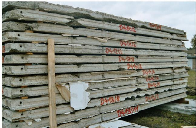
Abb. 36: Zwischengelagerte Deckenplatten
