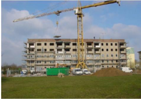
Abb. 32: Turmdrehkran
