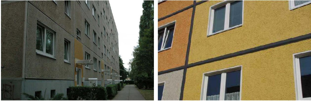
Abb. 7: Beispiel Fassade vor und nach der Fugensanierung
