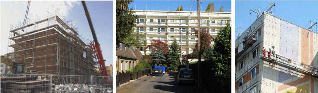
Abb. 5: Beispiel Fassadenrüstung, Fassadenhängerüstung
