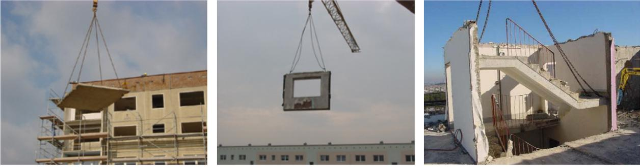
Abb. 24 - 26: Anschläge mit 4- und 2-Strang-Kettengehänge
