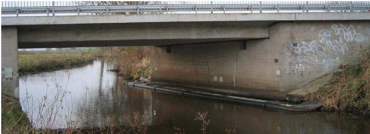
Abb. 35: Beispiel für eine Schwimmberme aus Kunststoff, welche nicht an dem Brückenbauwerk befestigt, sondern am Ufer verankert wird (Modellvorhaben in Schleswig-Holstein)
