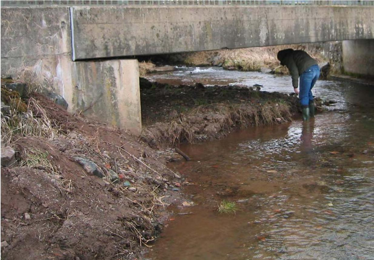
*Abb. 31: Beispiel einer nachträglich eingebrachten Berme mit guter natürlicher Gestaltung aber schlechter Anbindung an das Ufer*
