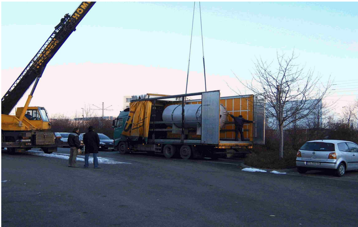
Abbildung 29: Anlieferung der Nachbehandlungsröhre
