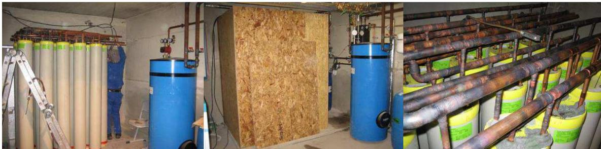
Bild 43-44: Latentwärmезellen, ohne und mit Verkleidung
