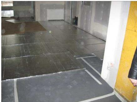
Bild 46: Montage VIP-Dämmung
