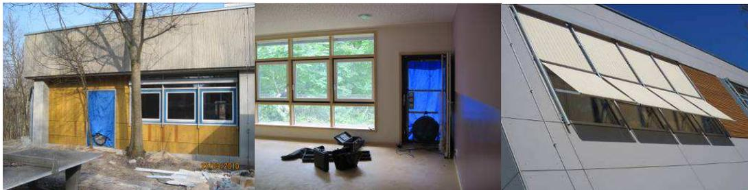
Bild 35-36: 1. und 2. Blower-Door-Test
