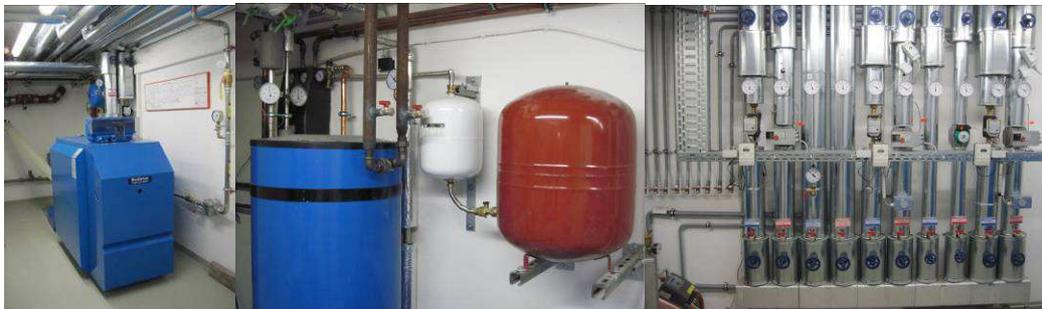
Bild 38: Gasbrennwertkessel
