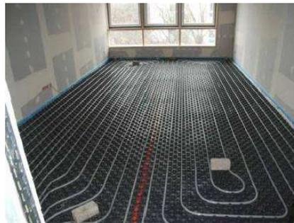
Bild 47: Montage Fußbodenheizung
