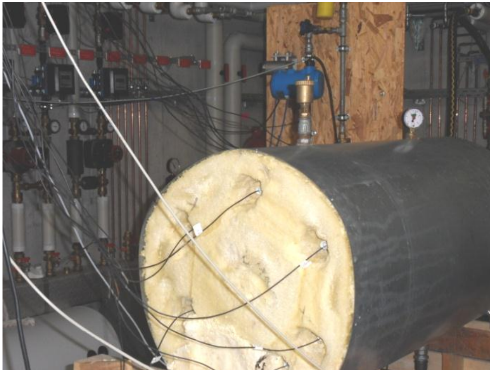
Abbildung 8.1 : Speicherprototyp auf dem System- und Speicherprüfstand
