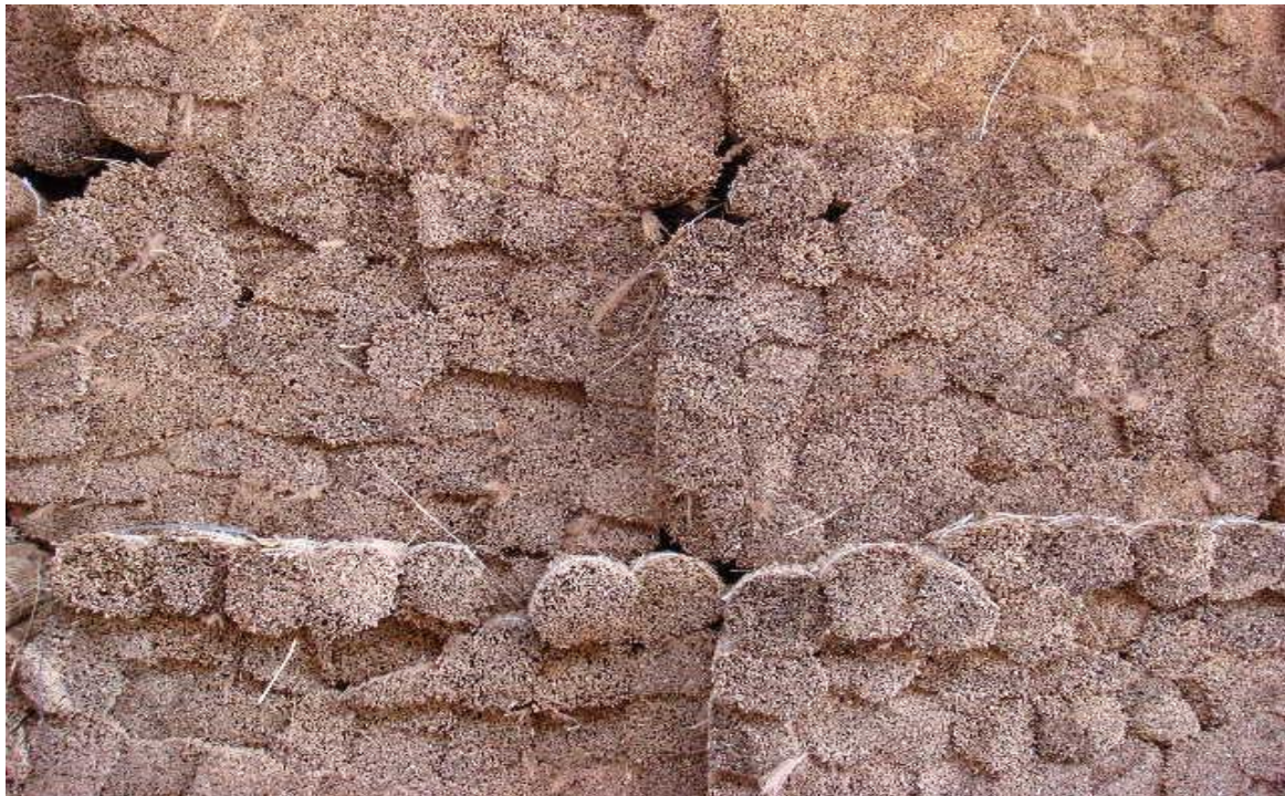
Einzelbunde in Großbunden zusammengefasst. Durch die hohe Verdichtung in den Großbunden, die durch das Übereinanderstapeln weiter verstärkt wird, sind die Reethalme einer hohen mechanischen Beanspruchung ausgesetzt. Die Einzelbunde verlieren dabei ihre ursprünglich runde Form und füllen die Freiräume zwischen den Bunden aus. Nasses Material kann unter diesen Umständen nicht nachtrocknen.
