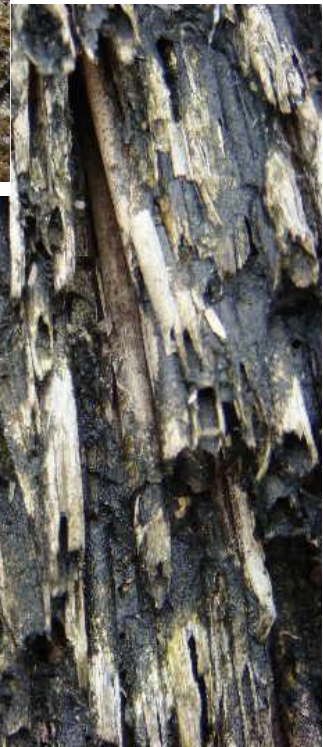
Linkes Bild : Auflösung der Halmstruktur in einem geschädigten Reetdach. Aus der Rotteschicht lassen sich Reste der Halme als Häckselgut leicht entnehmen.
