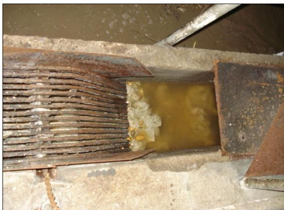
Abbildung 7-9: Rechen zur Feststoffabtrennung
