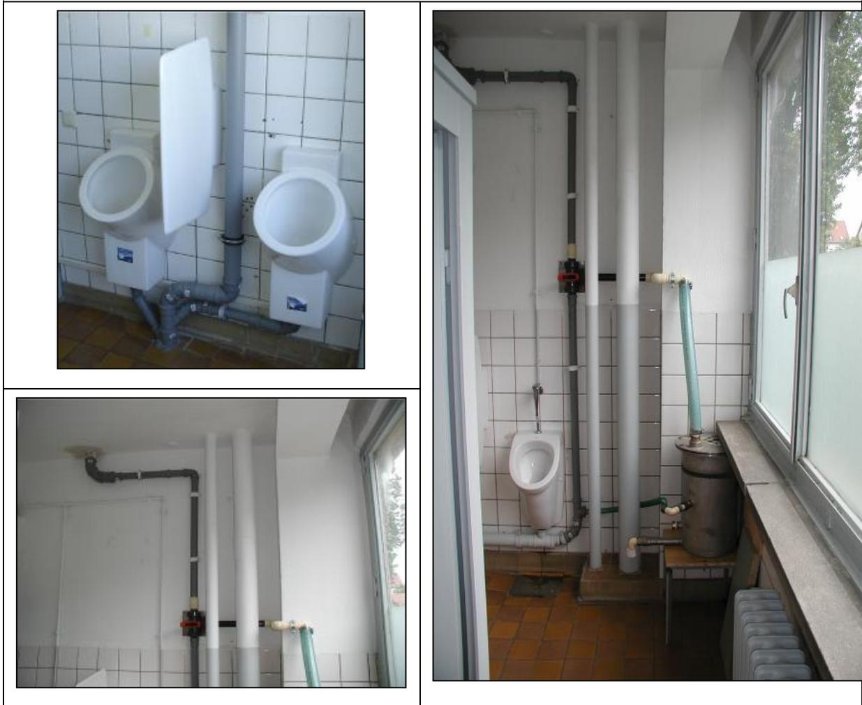
Abbildung 5-4: Erfassung des Urins aus wasserlosen Herrenurinalen (oben links); separate Ableitung (unten links) und Speicherung in einem Edelstahltank (rechts)
