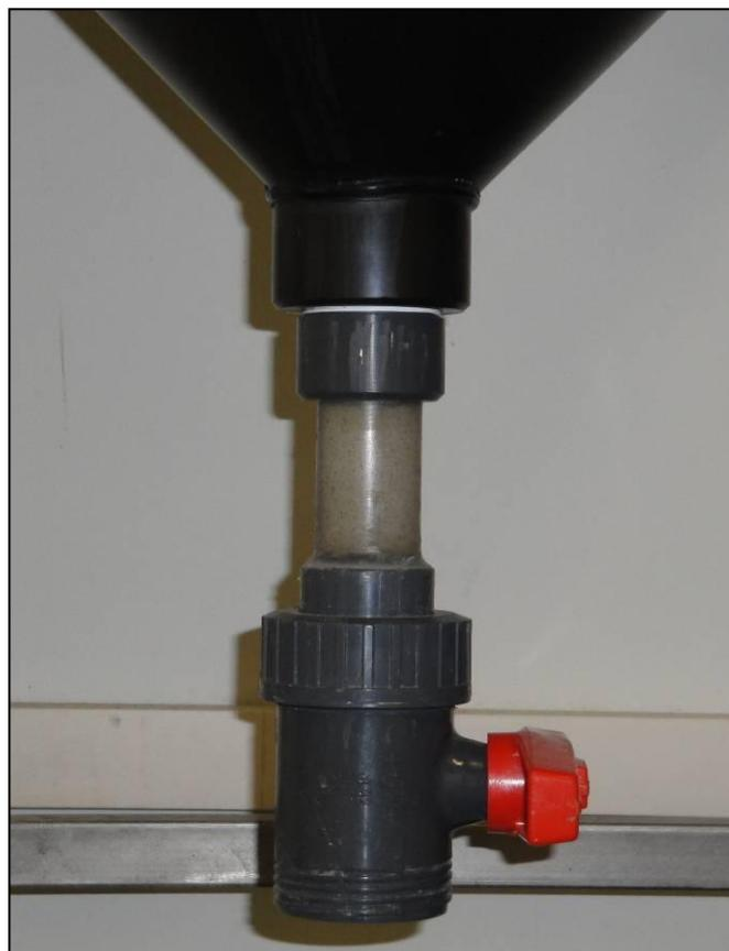
Abbildung 5-35: Plexiglasrohr an der Kegelspitze eines Zwischenklärbeckens
