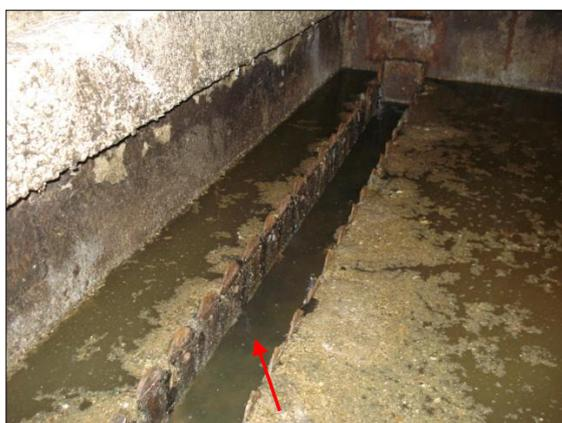
Abbildung 7-11: Schwimmschlammaustrag
