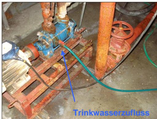
Abbildung 7-4: TW-Zufluss zur Wasserstrahlpumpe
