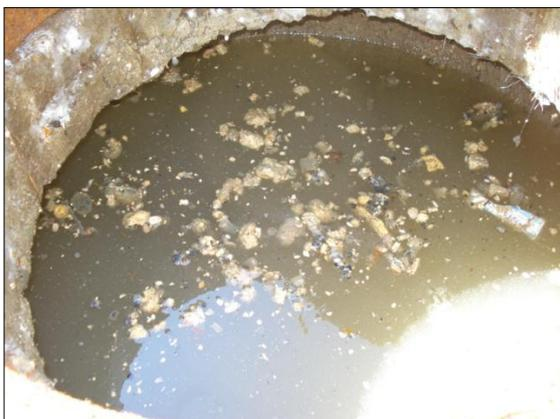
Abbildung 7-5: Einstau des Abwasserschacht 12
