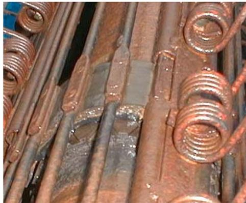
Bild 12 – Oberes Umlenkrohr mit aufvulkanisierten Gummibandagen
