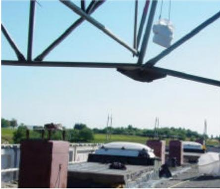
Bild 39: Transport der Big Bags mittels Kran (Foto Held, Ilmenau)
