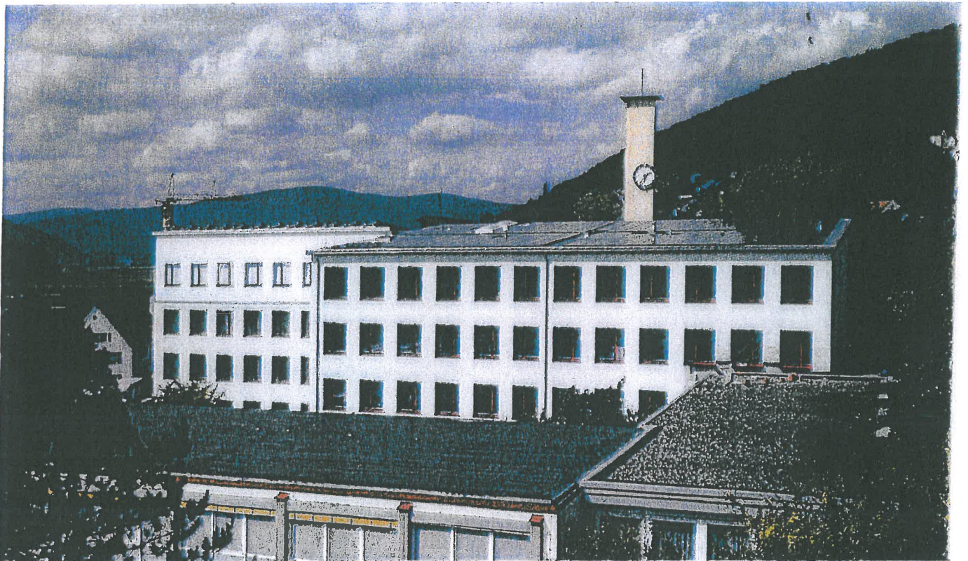
Sanierte Realschule Gemünden mit Photovoltaikanlage
