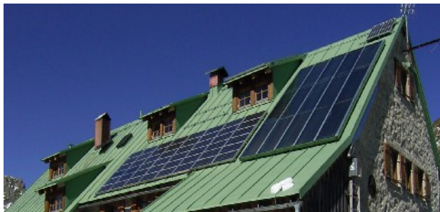
Abbildung 23: Dachmontage einer Anlage mit PV (links) und Solarthermie (rechts)
