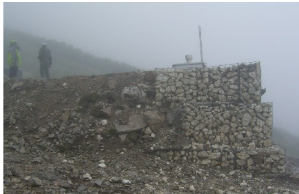
Abbildung 82: Eingesteinter Edelstahl-Hochbehälter - Watzmannhaus
