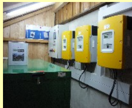
Inselwechselrichter mit BHKW
