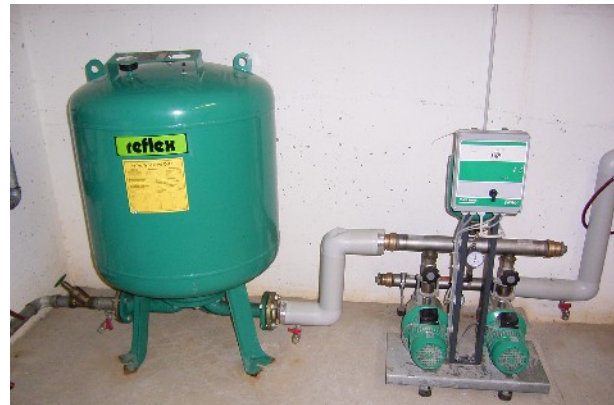
Abbildung 84: Druckerhöhungsanlage Rappenseehütte
