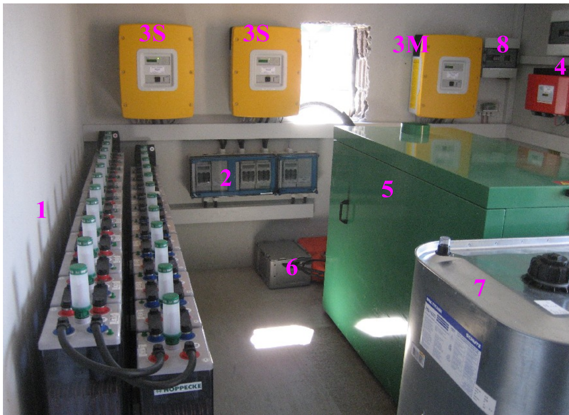
Abbildung 69: Typischer Aufbau einer dreiphasigen Hybridanlage in einer der 2008 modernisierten Hütten [H. Deubler]
