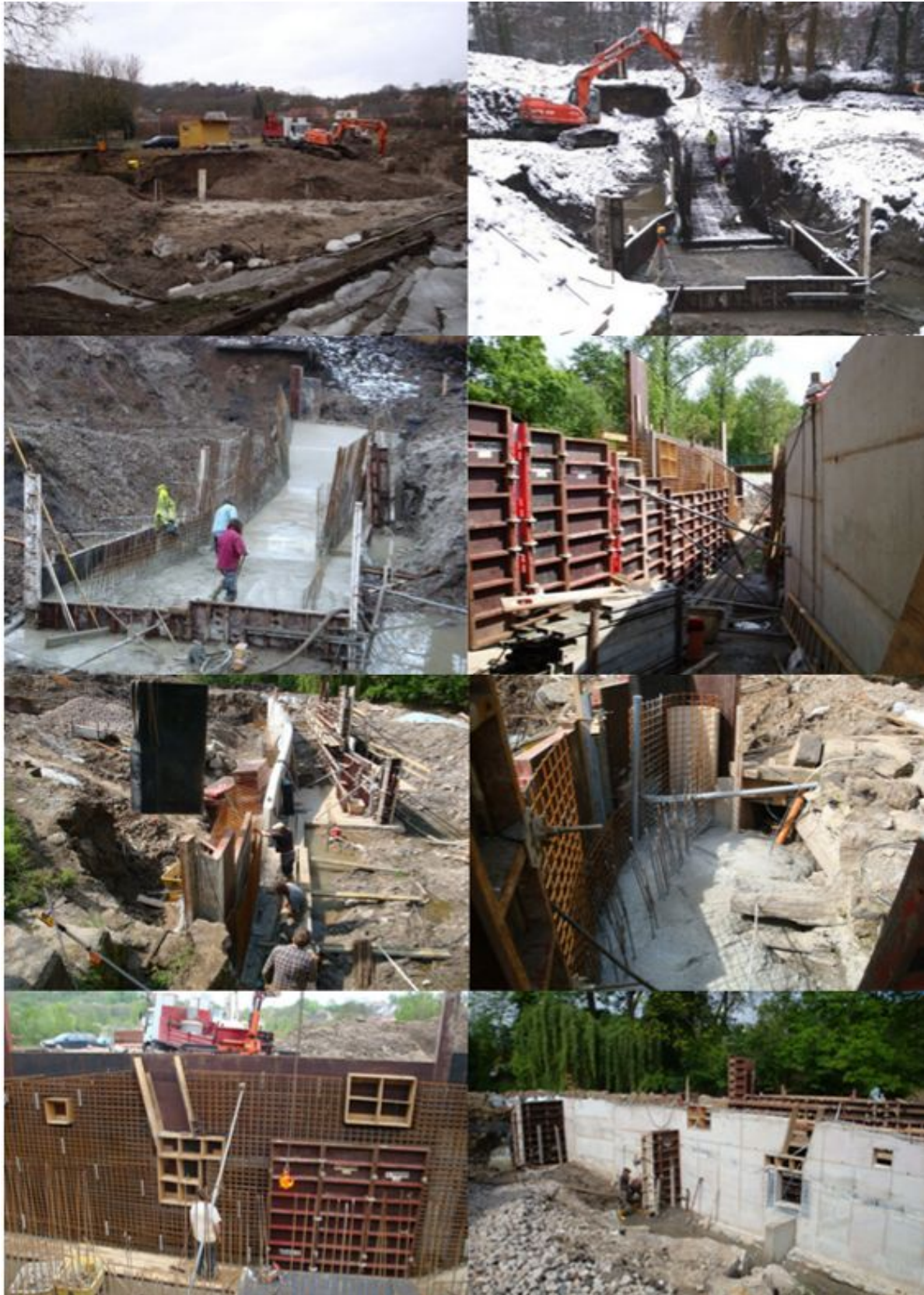
Abbildung 43: Beginn der Baumaßnahme, Schaffung des Troges
