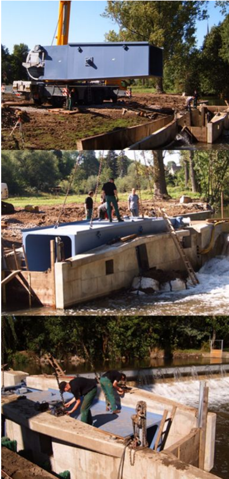
Abbildung 47: Einheben der Anlage
