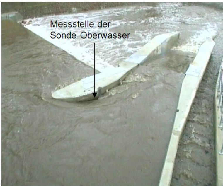
Abbildung 53: Messstelle der Sonde im Oberwasser, bei der sich bei Hochwasser eine deutliche Absenkung des Wasserspiegels erkennen lässt
