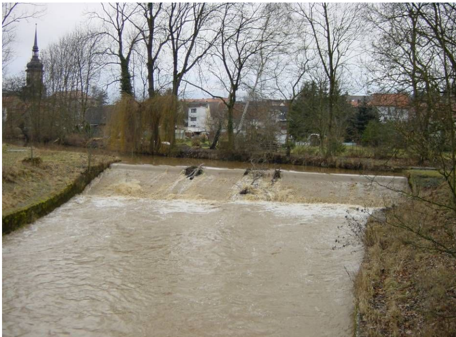
Abbildung 16: Wehranlage an der Ilm in Bad Sulza vom Unterwasser gesehen
