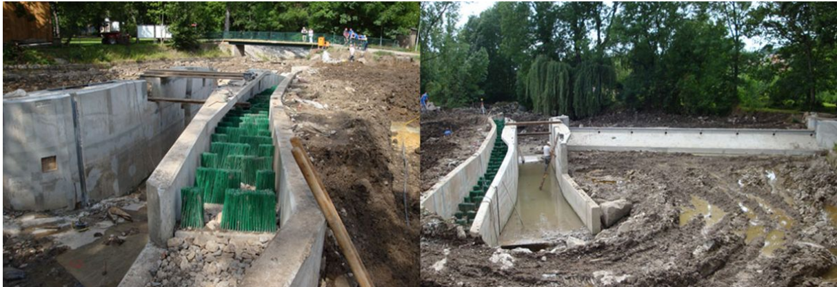
Abbildung 44: Bau des Borstenfischpasses
