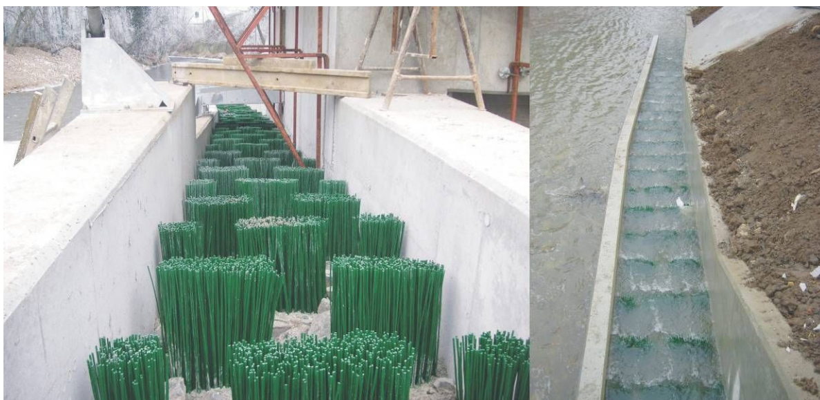
Abbildung 20: Darstellung eines Borstenfischpasses, der erfolgreich an der Unterliegerwasserkraftanlage in Bad Sulza installiert wurde
