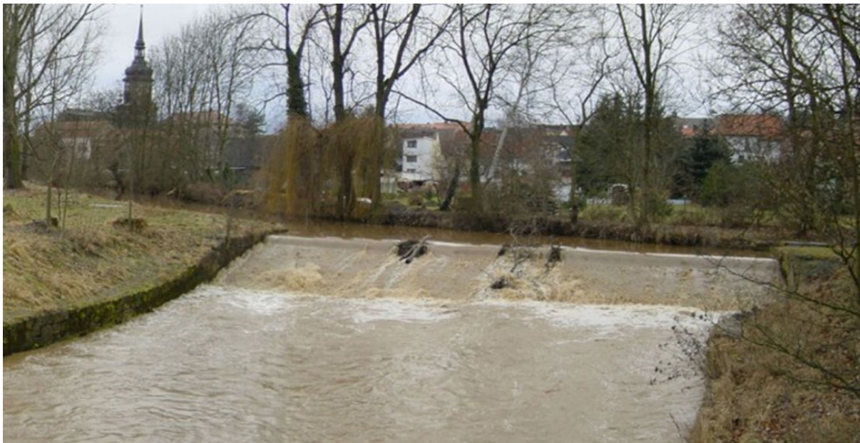
Abbildung 42: Ansicht der Stauhaltung vor Projektbeginn
