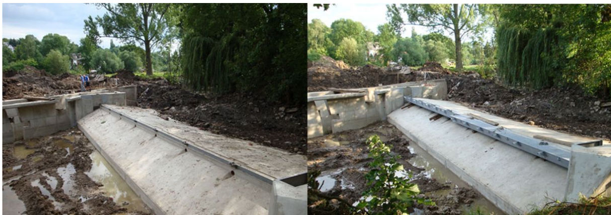
Abbildung 45: Sanierung der Wehranlage
