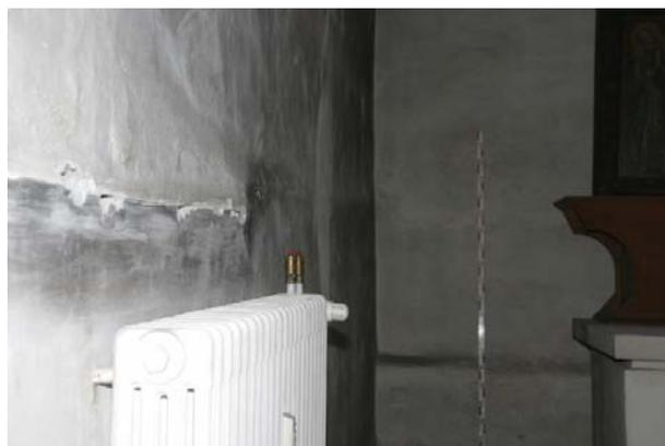
Abb. 27 Verschwärzung oberhalb Heizkörper
