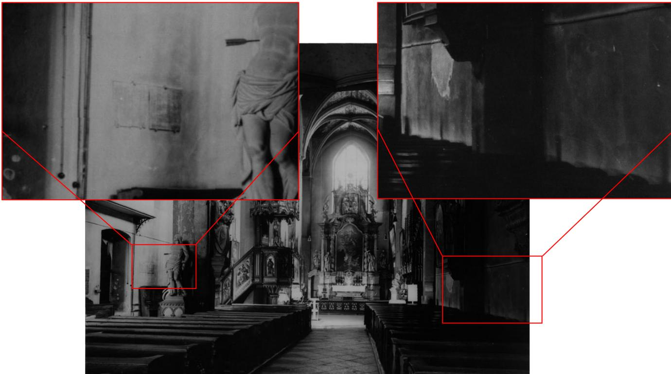
Abb. 18 Blick in die Klosterkirche, 1965, die Ausschnittvergrößerungen zeigen deutlich die Schmutzfahnen an den Wänden
