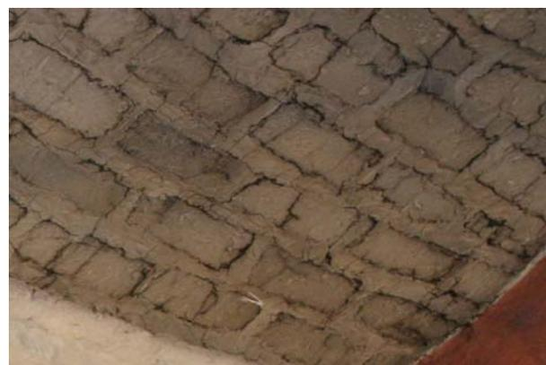
Abb. 41 Risse zwischen Fuge und Ziegel intensiv verschwärzt
