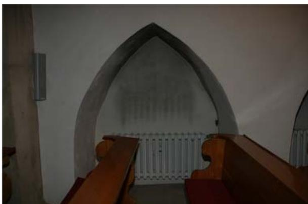
Abb. 20 Verschwärzung über Heizkörper
