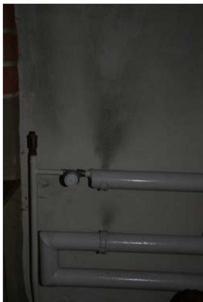
Abb. 22 Schwarzfärbung über Heizrohrbefestigung
