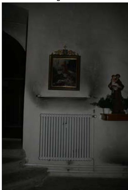
Abb. 24 Schwarzfärbung über Heizrohrbefestigung
