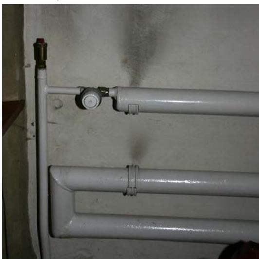
Abb. 51 meanderförmig verlegte Heiztrasse, Durch-
