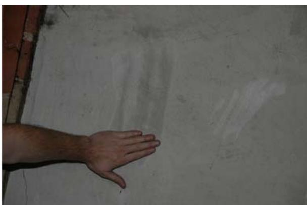
Abb. 38 Verschwärzung verschmiert auf der Oberfläche
