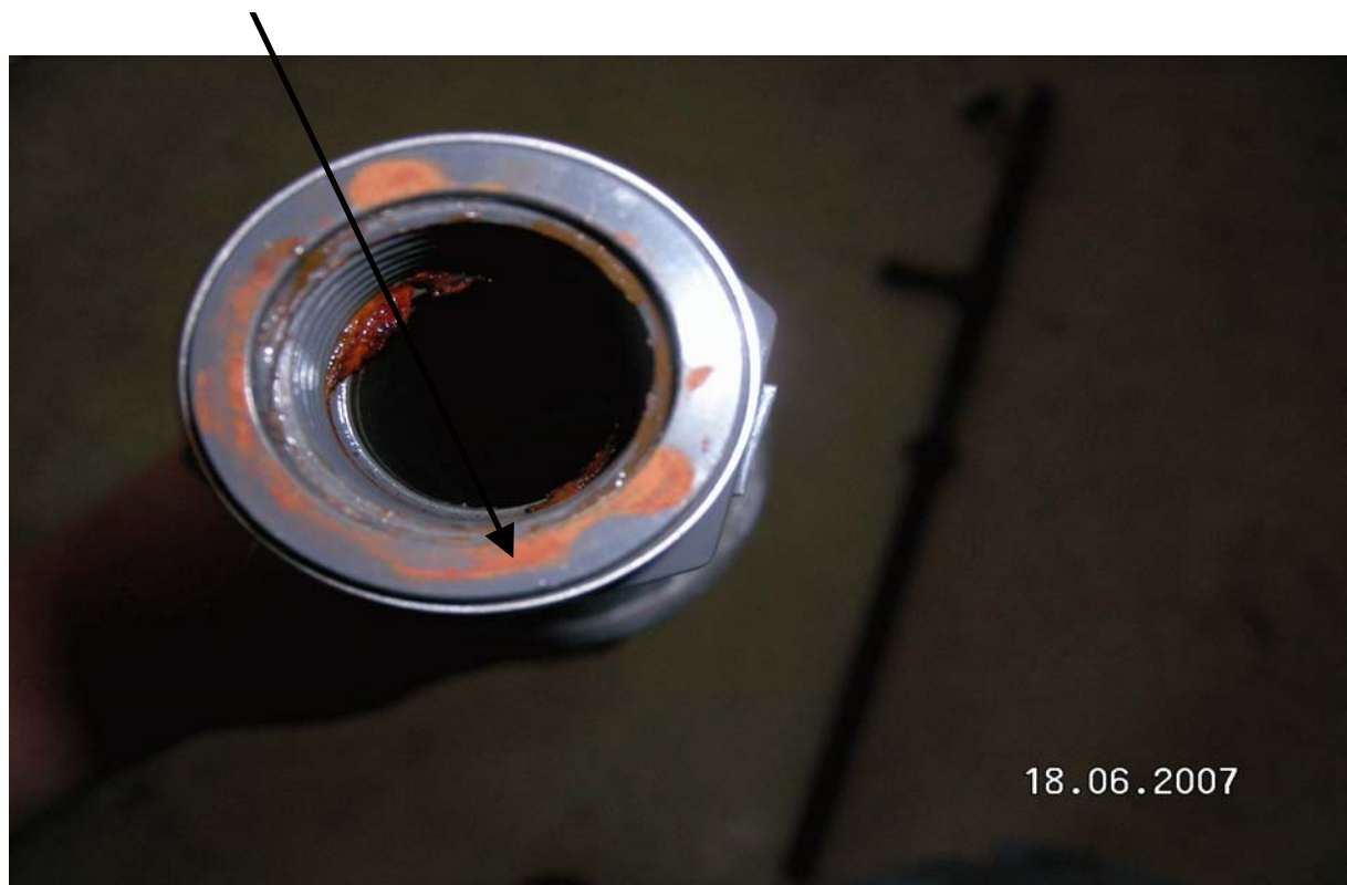
Abbildung 22: Innengewinde der Kunststoffpatrone unter dem Eisenrohr (ozonisiert); Rostrückstände, Verfärbungen des Kunststoffes durch die Migration oxidierter Eisenpartikel
