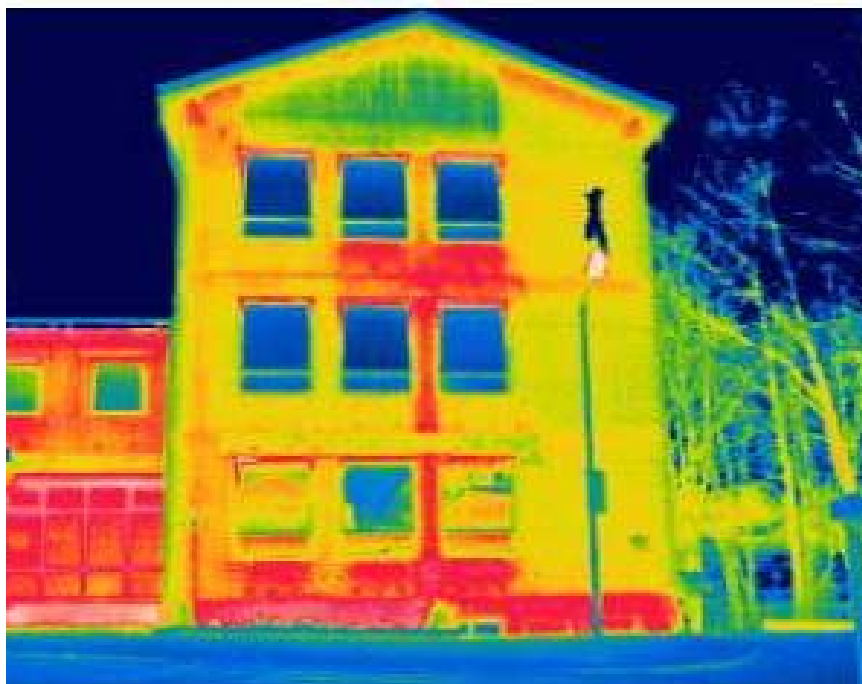
Bild 31: Fotoaufnahme (oben) und Thermographieaufnahme (unten) der Fassade vom Nordflügel des Gymnasiums.
