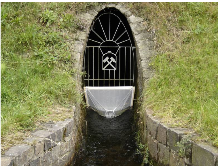
Abb. 14: Grundablass des Dittmannsdorfer Teiches mit Fangeinrichtung (Foto: K. Meißner).
