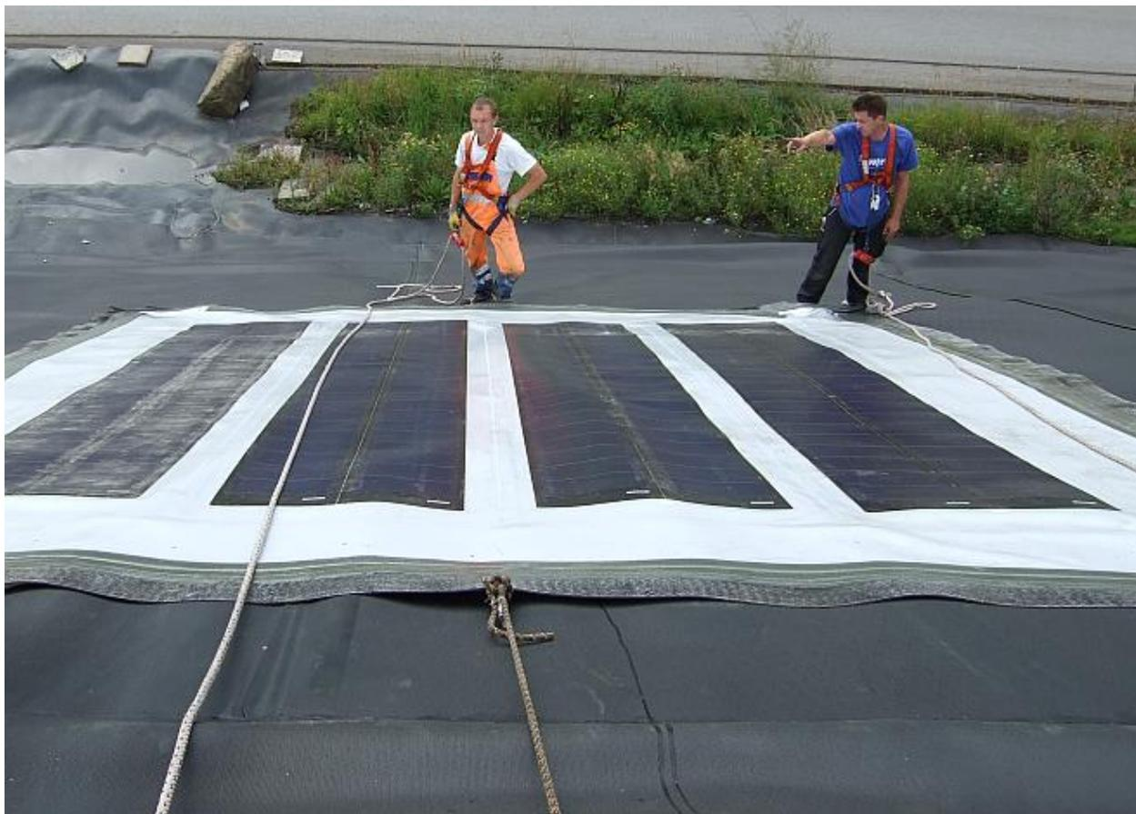
**Abbildung 3-17** Ausrichten eines Alwitra Testfeldes vor dem Verschweißen am Steilhang
