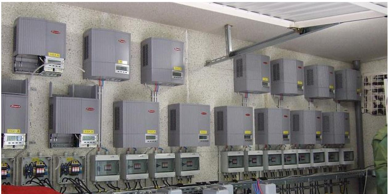
Abbildung 5-6 Wechselrichterstation
