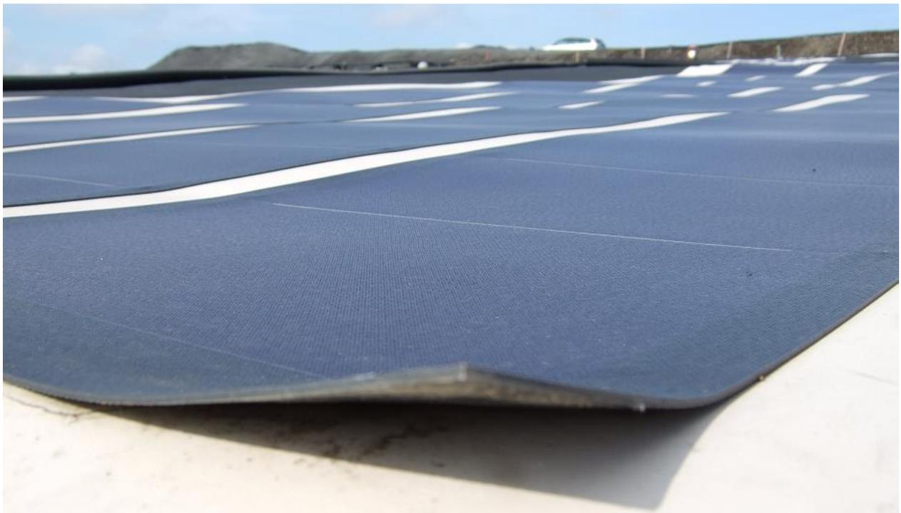
Abbildung 8-3 Eckablösung eines Dachbahnverbundes mit Produktionsfehler
