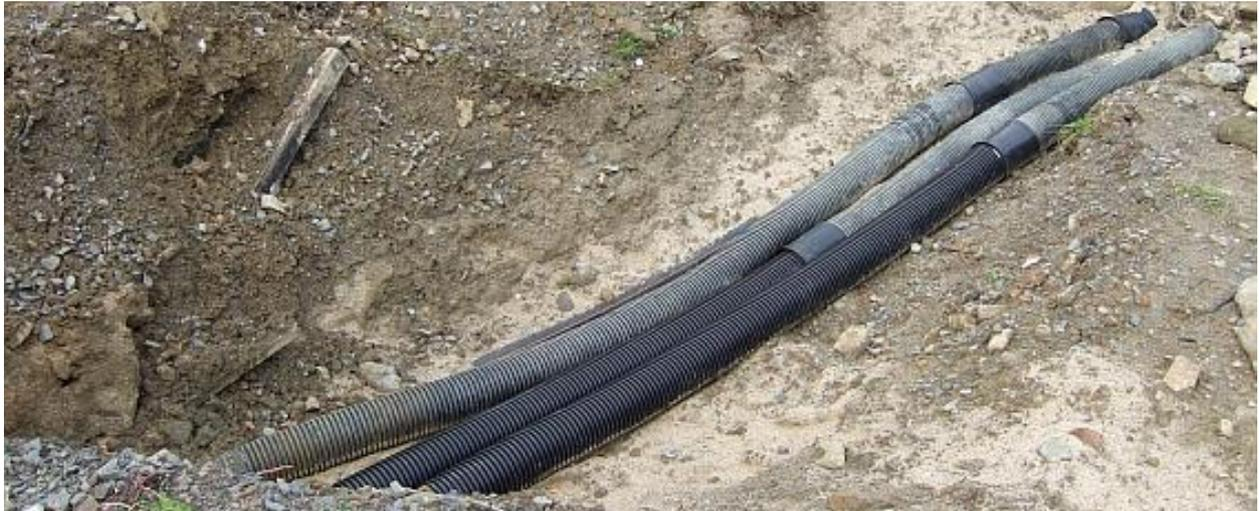
Abbildung 5-5 Kabelleerrohre zur Wechselrichterstation
