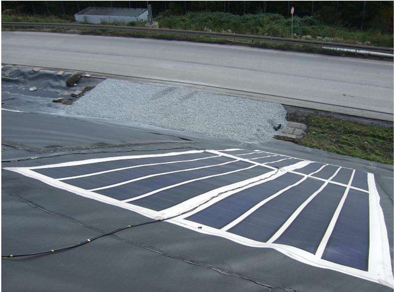
**Abbildung 3-14 Solar Integrated Testfeld im Steilbereich**
