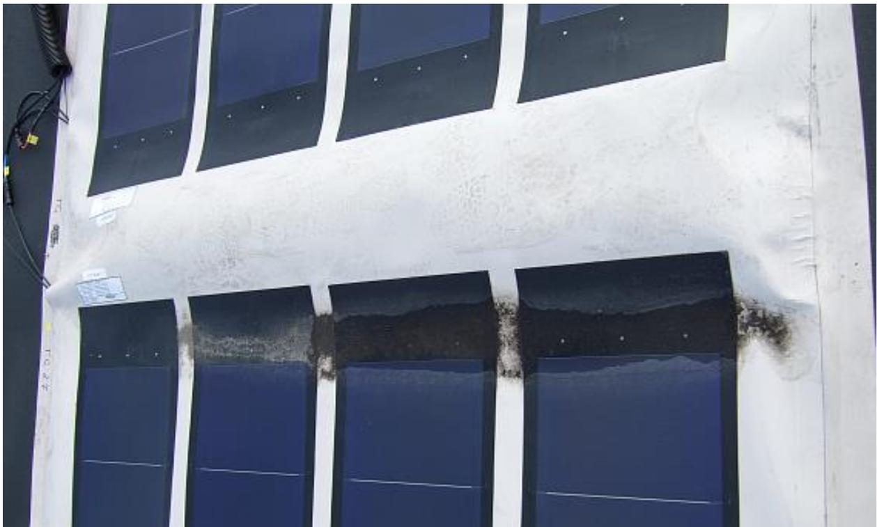
Abbildung 8-2 Vereinzelte Schmutzablagerungen im Flachbereich auf den Dachbahnfeldern
