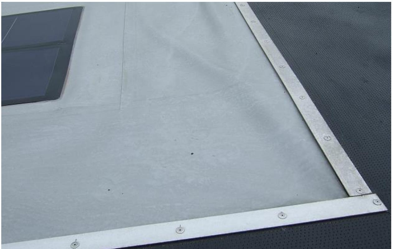
**Abbildung 3-20** Durch Metallprofile unterstützte Vernietung
