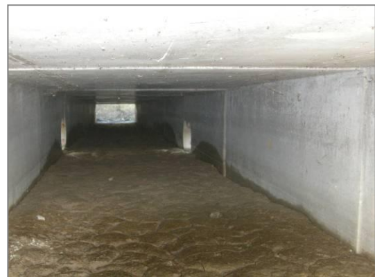
Abb. 6: (oben links): Lage der kontrollierten Straßendurchlässe bei Biebelried, Landkreis Kitzingen (Kastendurchlässe)
