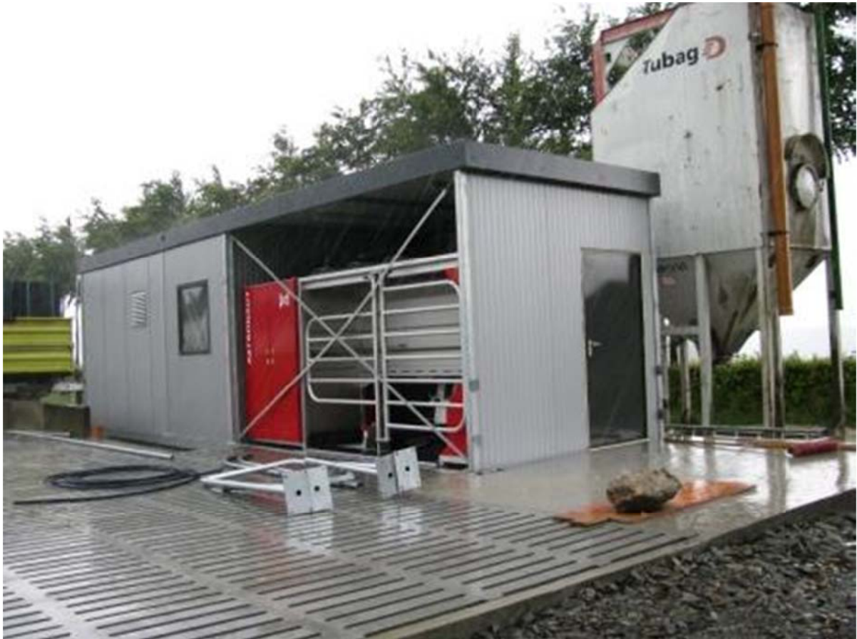
Foto: Einbau eines Melkroboters in einen mobilen Container
