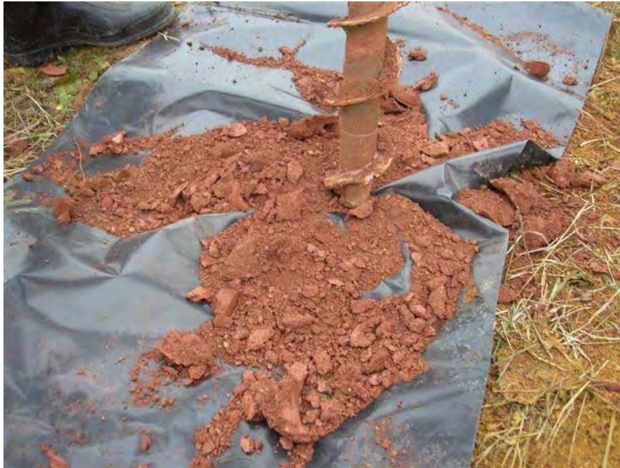
Abbildung 4-6 Sondierungsarbeiten durch Bohrungen bei Hořenec
