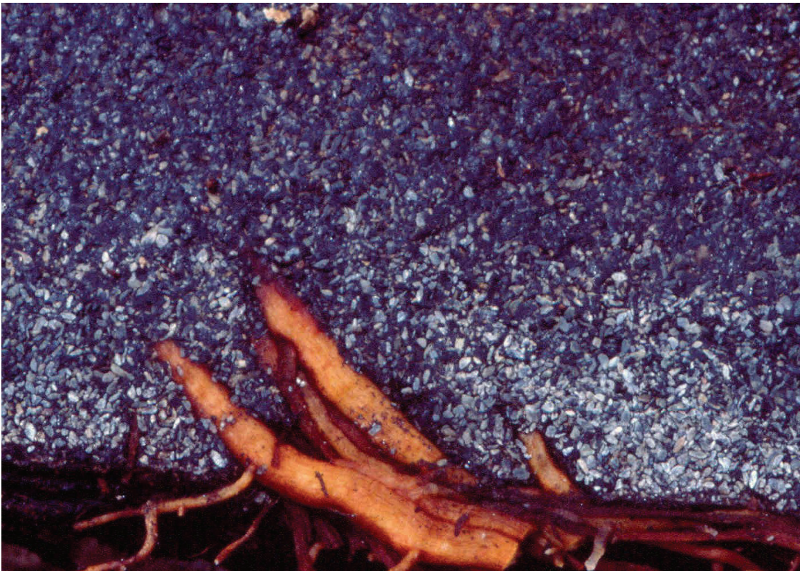
Abb. 44: Wurzeleindringungen von Ficus carica (Ring 3)
