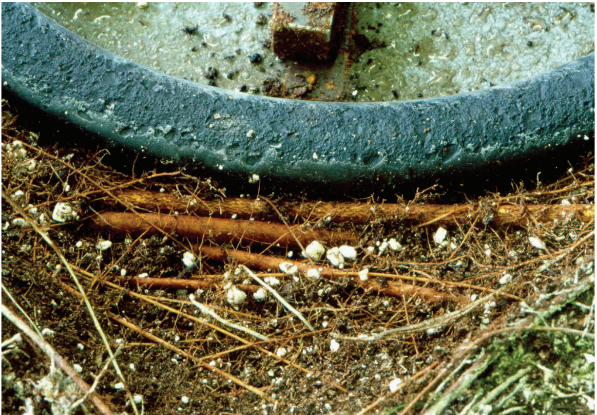
Abb. 81: An Dichtungsring 1 anliegende Wurzeln von Ficus benjamina
