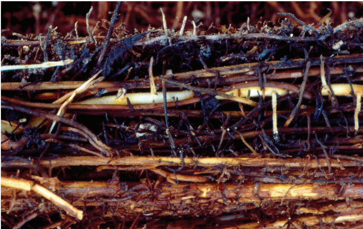
Abb. 82: An Dichtungsring 1 anliegende Wurzeln von Ficus benjamina (nach Entfernen des Rings)
