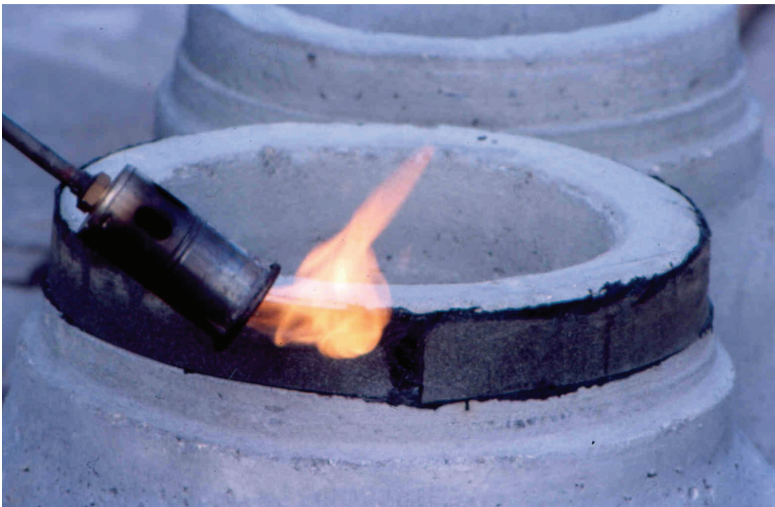
Abb. 3: Auf das Spitzende aufgeschweißter Bitumenring
