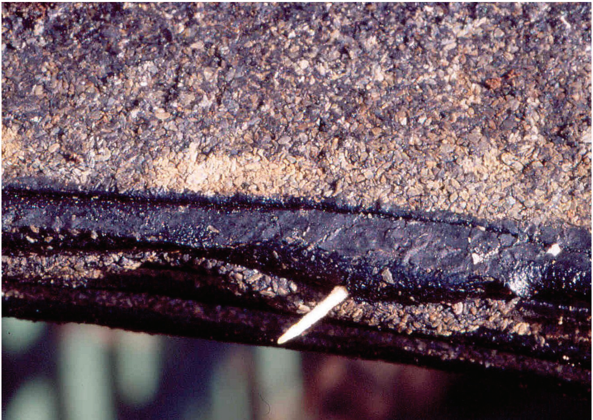
Abb. 64: Wurzeldurchdringung von Pyracantha (Ring 5)
