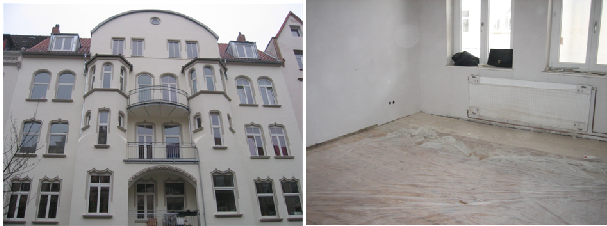
Abb. 11: Wohnhaus "Im Moore 35" (links) und Holzbalkendecke (rechts)
