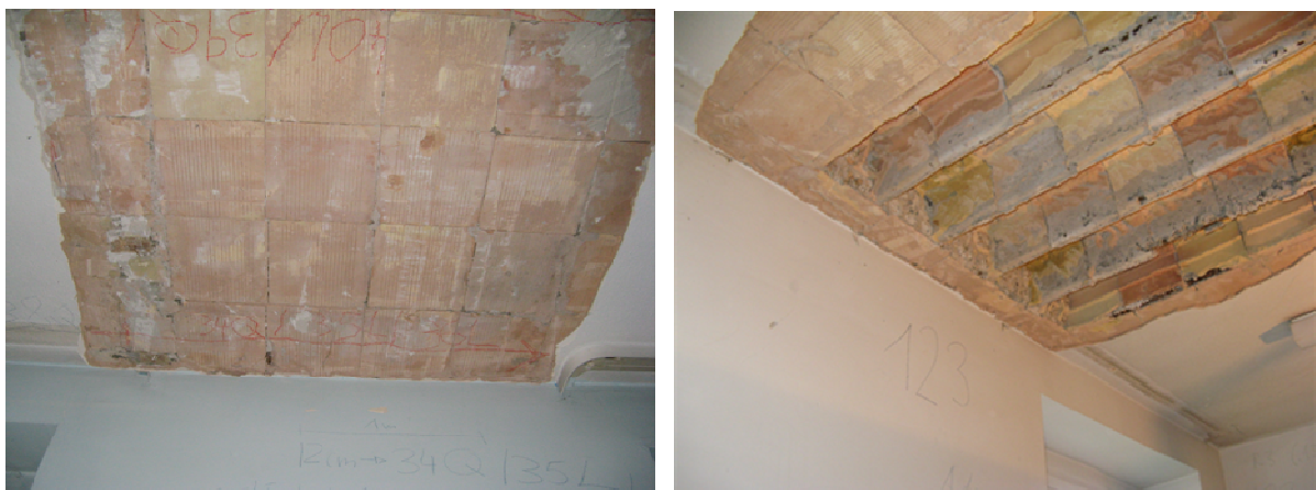
Abb. 30: Deckenuntersicht - links: vollständige Decke; rechts: Deckenstreifen ohne Ziegel
