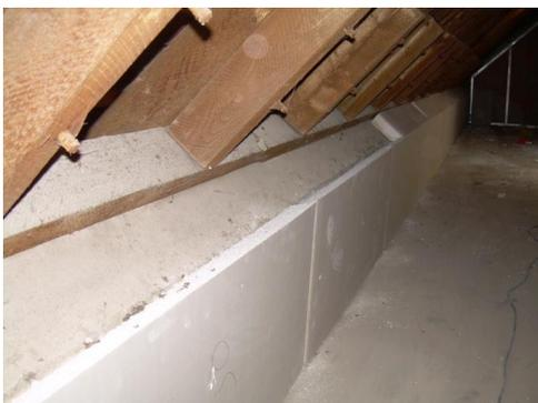
Bild 8: Dämmung Abseitenwände
