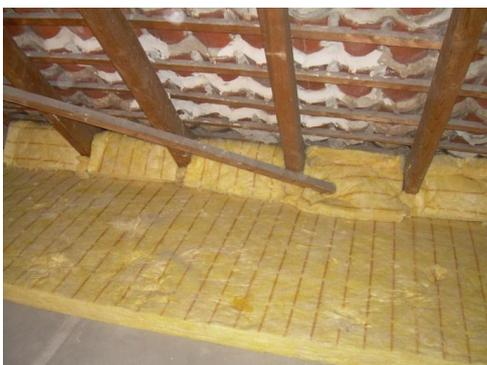
Bild 11: Dachfußbodendämmung Seelsorgeamt
