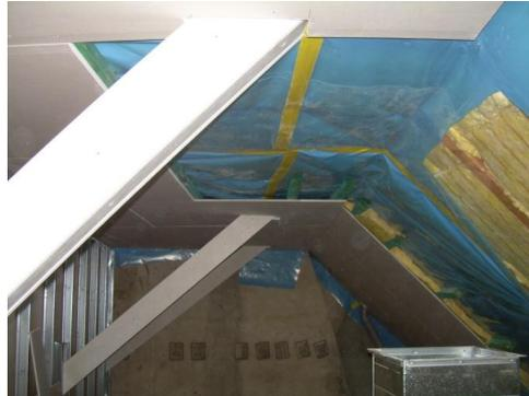
Bild 6: Schrägdachdämmung Kopfbau
