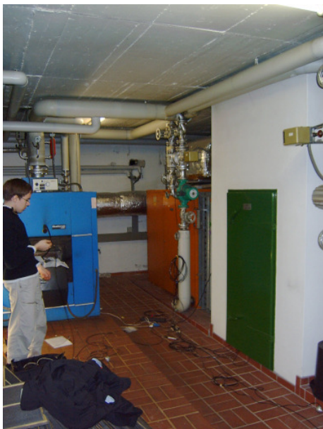
Abbildung 14 - Messungen an den Kesselanlagen
