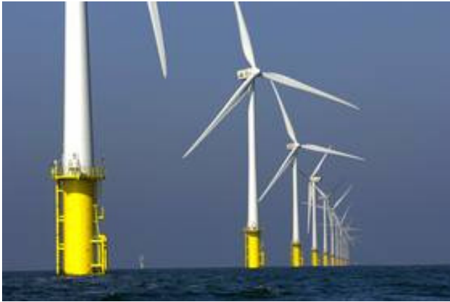
Abb. 7: Windpark Egmont aan Zee, Niederlande Bild: http://www.noordzeewind.nl
