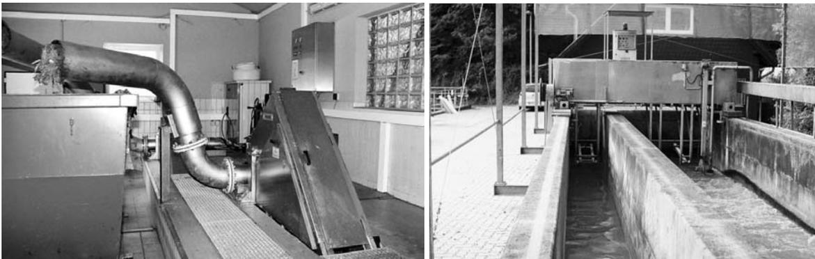
**Abbildung 5.65: Mechanische Reinigungsstufe der Anlage K3 (links: Rechenanlage, rechts: Sand- und Fettfang)**
