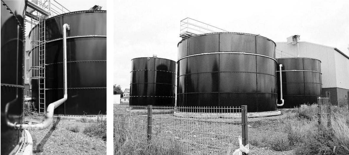
**Abbildung 5.189: Erweiterte Abwasserbehandlungsanlage (links: Rezirkulationsrohr aus dem Membran- zum Belebungsbecken)**
