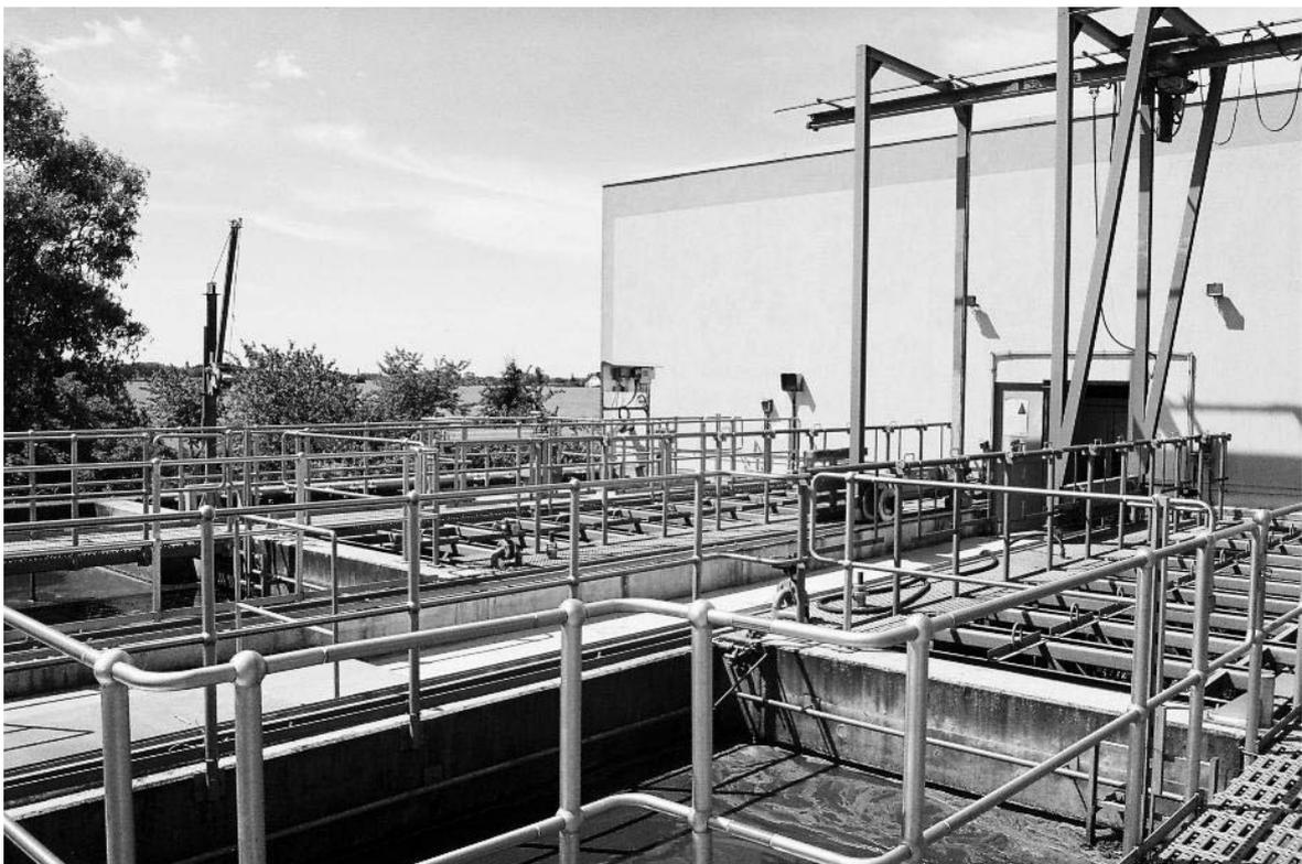
**Abbildung 5.41: Biologische Reinigungsstufe der Anlage K2 (Blick vom DN-Becken der Straße 1 auf Straße 2)**
