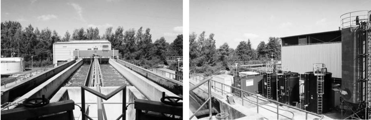
**Abbildung 5.97: Sandfang (links), Chemikalienlager (rechts)**
