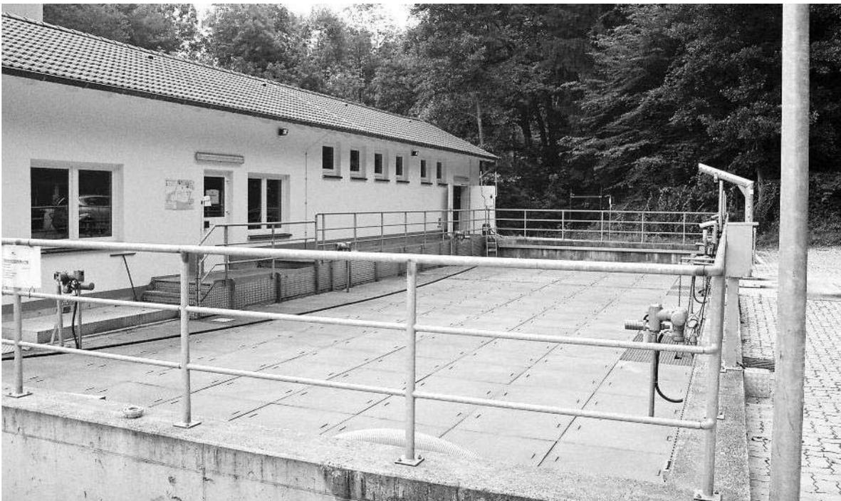
**Abbildung 5.68: Membranbelebungsstufe der KA K3 mit abgedeckten Becken**
