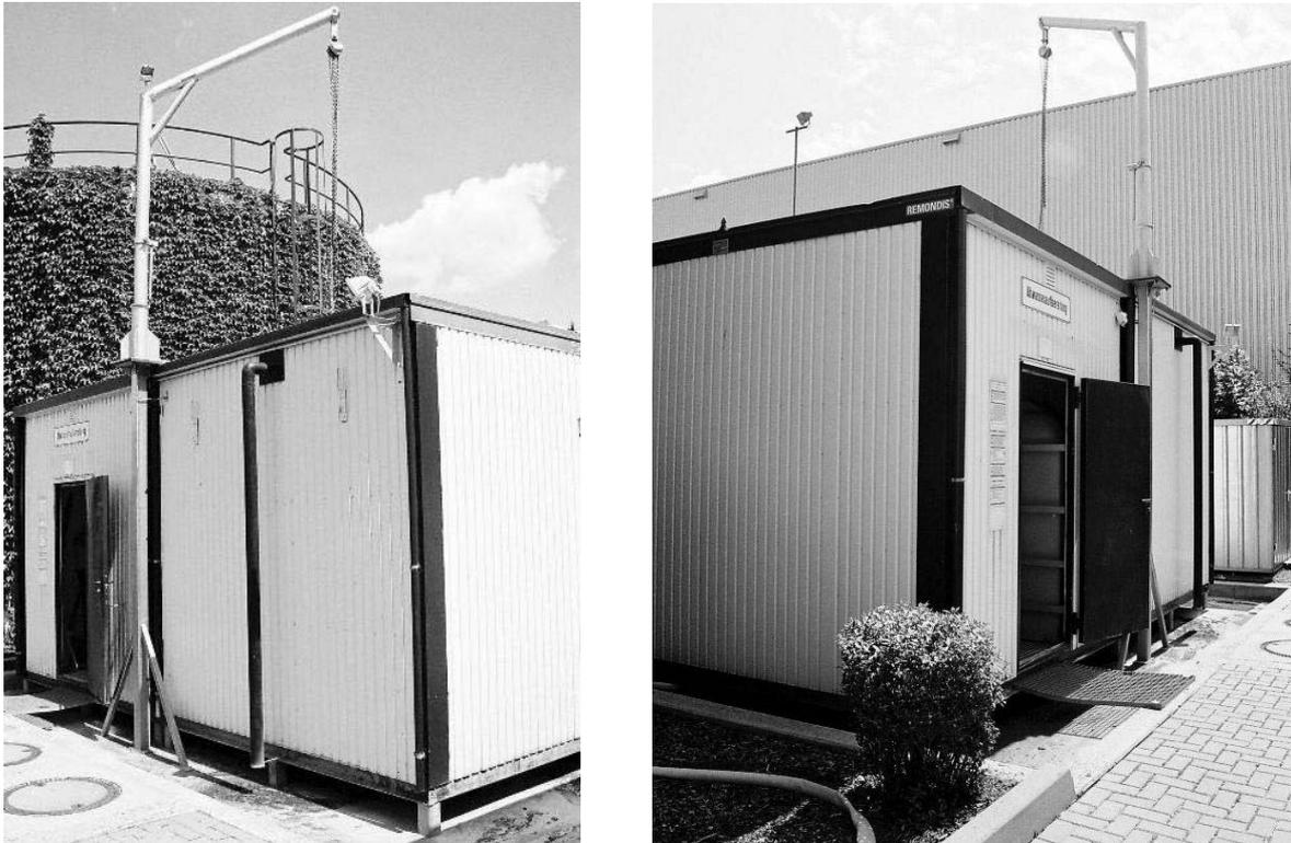
**Abbildung 5.242: Betriebskläranlage I4 – Biologische Behandlungsstufe (links, im Hintergrund), Container für Prozesstechnik und Filtration**
