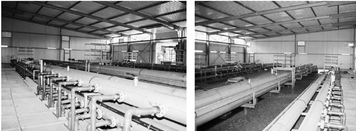
**Abbildung 5.96: Biologische Reinigungsstufe der KA K4 (Nitrifikationsstufe mit getauchten Membranmodulen)**
