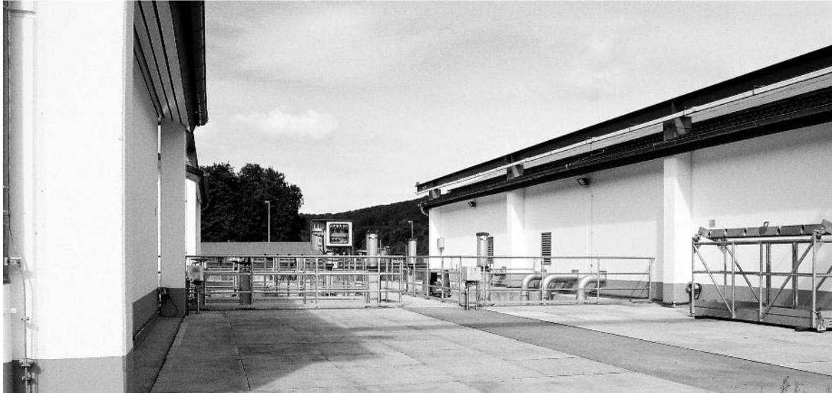
**Abbildung 5.4: Membranbelebungsstufe der Anlage K1 mit abgedeckten Becken**
