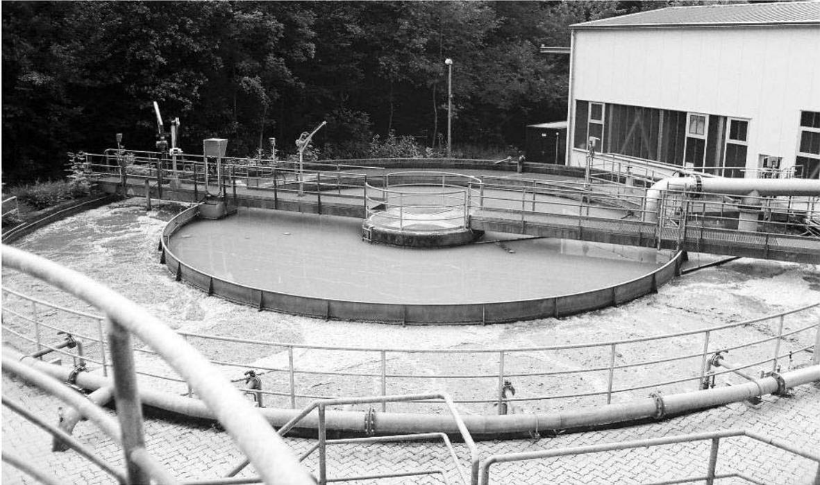
**Abbildung 5.67: Mechanische Abwasserbehandlung im Innenring des Kreisringbeckens und erster Stufe der biologischen Behandlung im Außenring**
