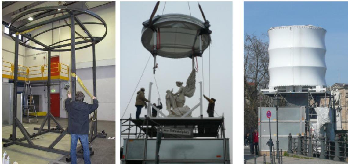
*Stahlskelett Versuchsaufbau Montage*
