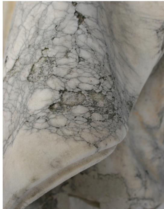
Abb. 29 Schlossbrücke, Figur 4, krakellierte schichtenparallele Ablösungen der Marmoroberfläche
