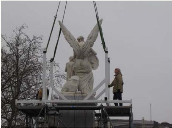
**Abbildung 24:** Aufstellen des unteren Segments an der Skulptur mit Hilfe eines Krans
