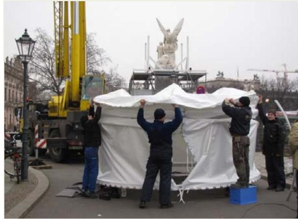
**Abbildung 25:** Aufspannen der Membran auf das obere Segment
