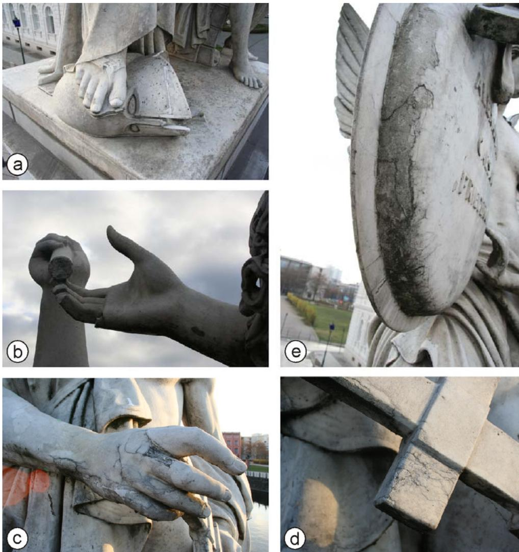
Abb. 2 Schadensbilder der südlichen Figurengruppen: a) verschlossene Risse und Ergänzungen an filigranen Objektteilen, b) abgebrochene Elemente, c) stark entfestigtes Marmorgefüge mit Makrorissbildungen, c) Ausbrüche und komplexe Rissbildungen (Krakeleestrukturen) und e) Rissbildungen sowie Abplatzungen exponierter Bereiche.
