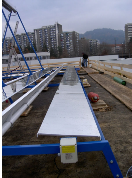
Abbildung 20: Antrieb einer Primärspiegelreihe
