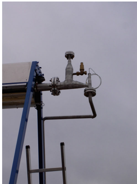
Abbildung 21: Anschlussflansch mit Temperatur- fühler und Entlüftungsventil
