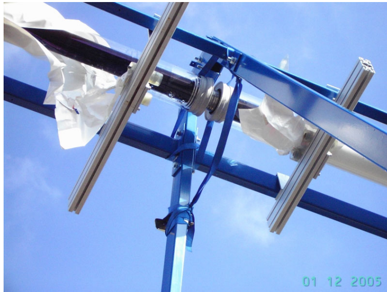
Abbildung 18: Vorbereitung zum Verschweißen der zwei Absorberrohre.
