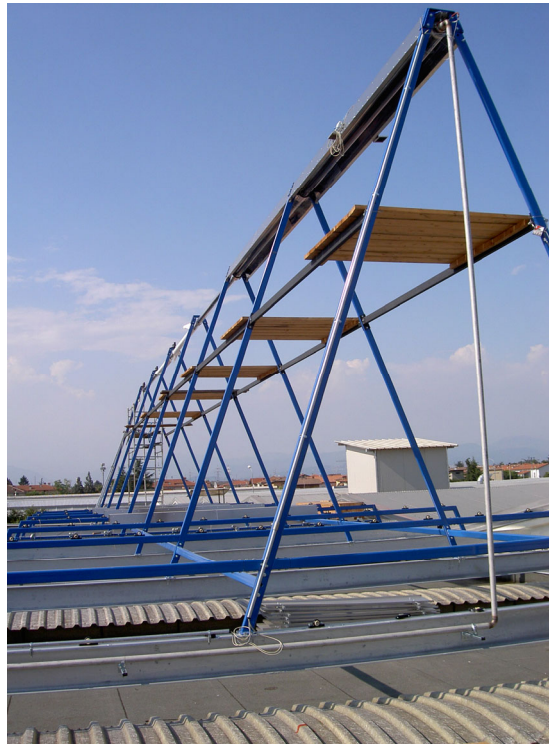
Abbildung 45: Montage der Absorberrohre und der Receiver
