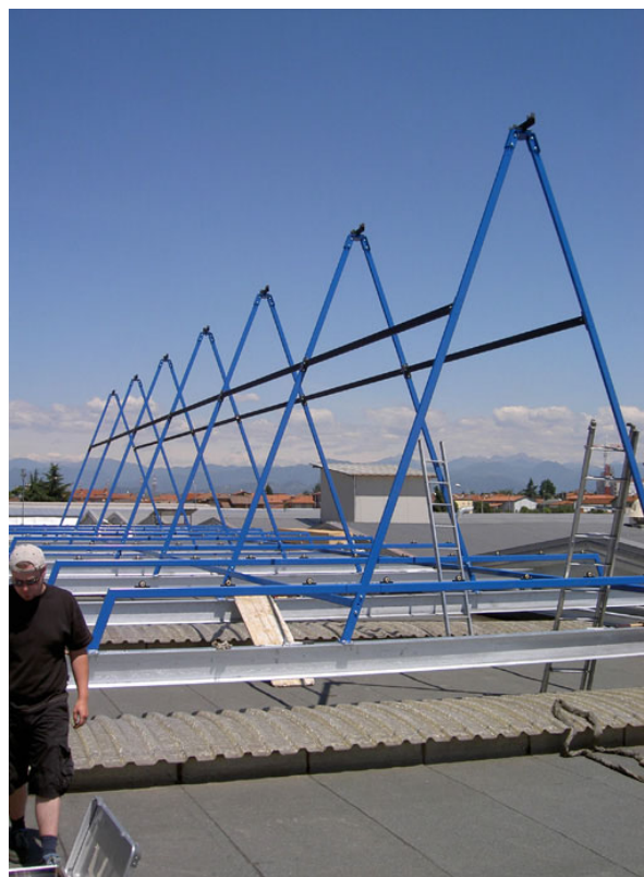
Abbildung 44: Stahlstruktur mit Querstreben für Montageplattformen
