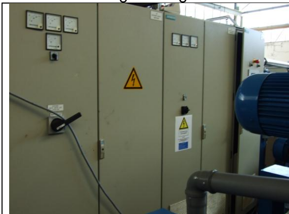
Abb. 3.13: Hochstromanlage I Dr. Laure Plasmatechnologie GmbH Leistungsdaten I = 500 \text{ A} U = 250 \text{ V}
