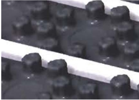
Abbildung 8 verlegte Noppenplatte mit Heizungsrohr
