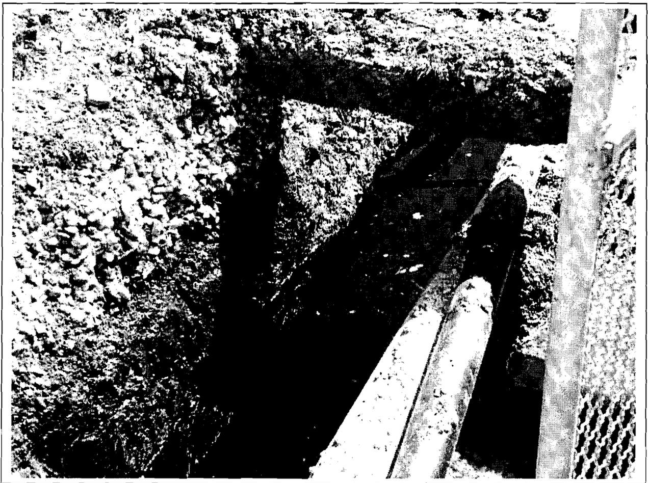
Abb. 4: Suchschlitz entlang der Zulaufleitung Kleinkläranlage. Der Kanalgraben ist mit ausgetretener Jauche vollgelaufen
