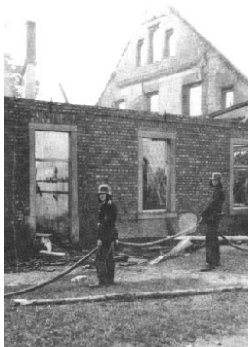
Abbildung 6: Das abgebrannte Hofgebäude 1942 ( aus: Geschichte der Stadt Rhede; 2000; HRSg Heimatverein Rhede; S. 854)
