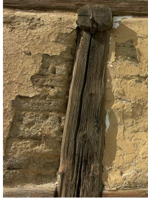
Ausbeulen/Ablösen des Lehmputzes sowie fortschreitendes Auswaschen der Lehmsteinausmauerung
