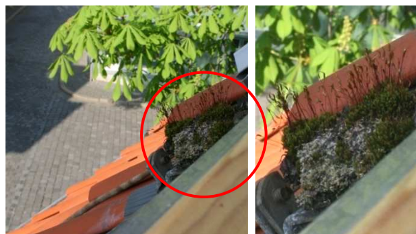
Abb. 111 Die Bemoosung am unteren Anschluss des Dachflächenfensters sollte entfernt werden. (DFWZ QLB)
