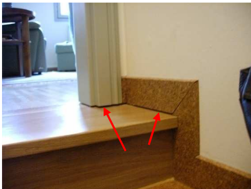
Abb. 65 und 66 Setzung des Fußbodens mit Abriss der Bodenbeläge von der Randleiste (DFWZ QLB)
