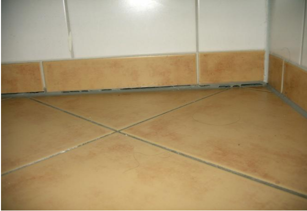
Setzung des Fußbodens mit Abriss der Bodenbeläge von der Randleiste, links im Bad, rechts im Flur
