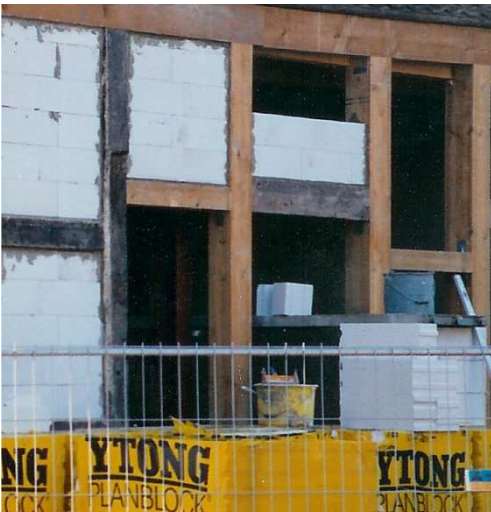
Abb. 51 Das Schließen der Gefache erfolgte mit großformatigen YTONG-Steinen, geklebt, ohne Dreikantleiste (DFWZ)
