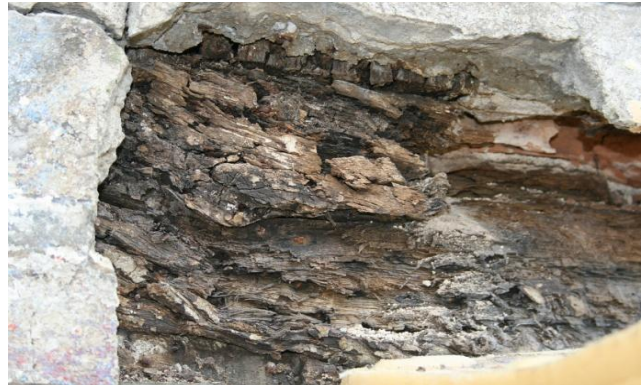
Pilz- und Schwammbefall an den Schwellhölzern im Erdgeschoss (links) und im Obergeschoss (rechts)
