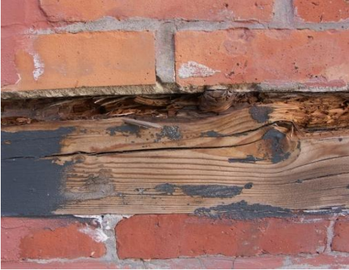
Ablösen des Gefacheanstrichs, hauptsächlich an der Westfassade
