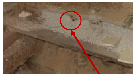
Fußbodenaufbau mit in der Schüttung verlegten Heizungsrohren
