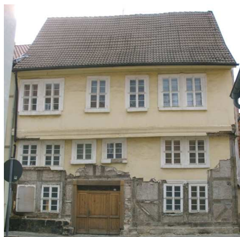
Abb. 16 nachträglich verputzter Fachwerkbau (DFWZ)
