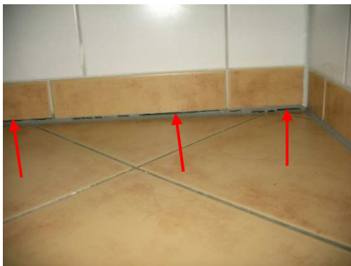
Abb. 65 und 66 Setzung des Fußbodens mit Abriss der Bodenbeläge von der Randleiste (DFWZ QLB)
