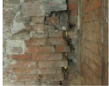
Abriss von der rechts anstoßenden Wandscheibe D
