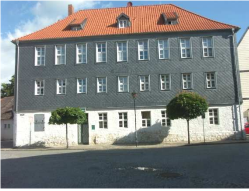
Abb. 17 nachträglicher Schieferbehang (DFWZ)
