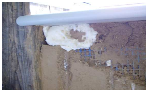
Abb. 101 Auf den letzten Holzleichteilmstein der Innendämmung unterhalb der Fensterbank wurde verzichtet. (DFWZ QLB)
