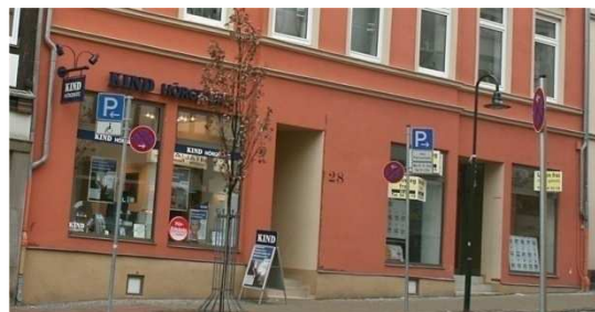
Abb. 15 durch Ladeneinbauten und nachträglichen Verputz veränderte Straßenfassade (DFWZ)
