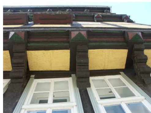
Abb. 6 Stockwerksüberstände und Knaggen mit Tropfkante (DFWZ)
