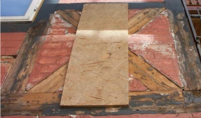
Rissbildung, Versprödung und großflächiges Ablösen des Farbanstrichs von den Fachwerkhölzern
