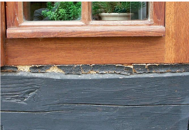
Ablösen des Anstrichs von der Füllmasse, Verwitterung der Korkfüllmasse
