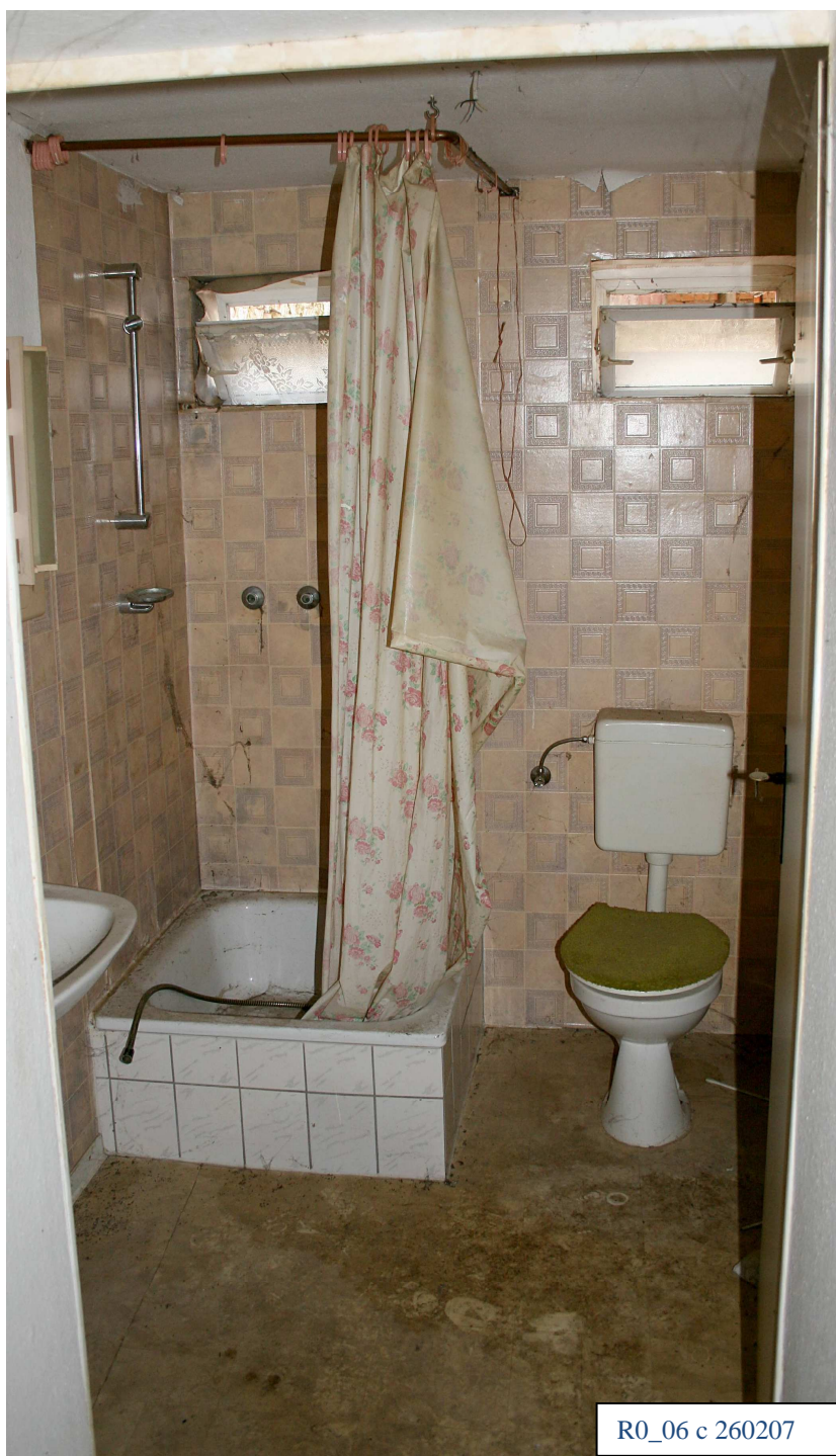
Übersichtsfoto Bad im Erdgeschoss (Raum 0.06), Wand b und c, Zustand 26.02.07
