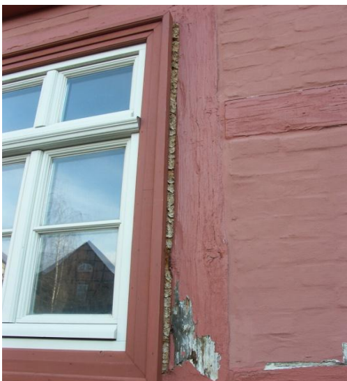
Ablösen des Anstrichs von der Füllmasse, Verwitterung der Korkfüllmasse
