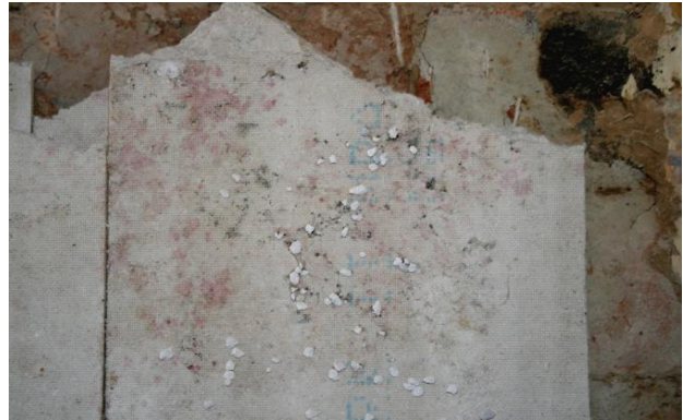
Rot- Schwarz- und Blauschimmel an/in beiden Lagen der Verbundplatte
