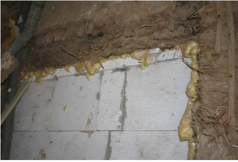
Abb. 93 Mit Ytong-Steinen und Bauschaum schnell geschlossenes Gefach, Innenansicht,
