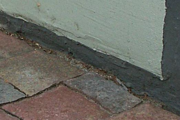
Fäule- und Pilzbefall an den Schwellhölzern im Erdgeschoss (2 Objekte - 1 Bauherr)
