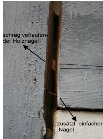
unfachmännische Verbindung Ständer-Riegel
