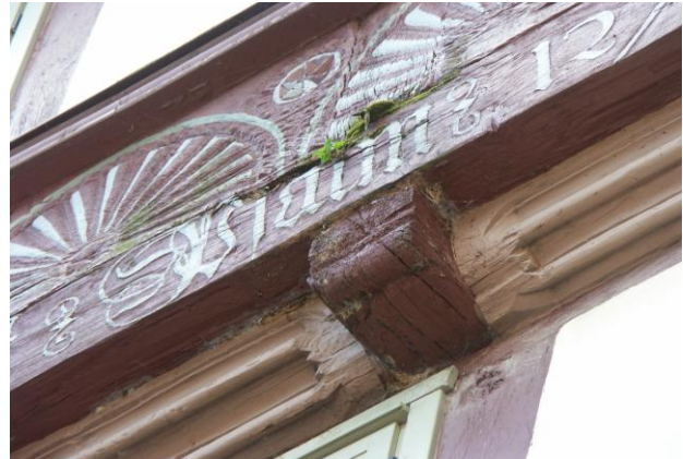
Moderfäule/Pilzbefall und Pflanzenbewuchs der Brüstungsplatten, Schwellhölzer und Balkenköpfe
