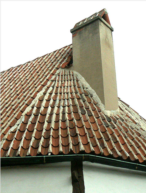
Abb. 7 Ziegeleindeckung mit Kalkleiste: Wordgasse 3 Quedlinburg (DFWZ)
