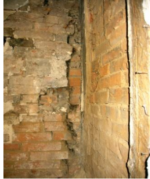
Abriss von der rechts anstoßenden Wandscheibe D
