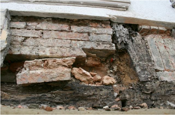
Schwammbefall an den Ziegelsteinen der angrenzenden Gefache, Zerstörung der Steinstruktur
