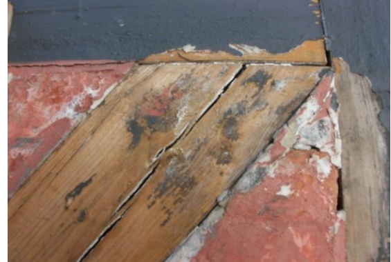
Rissbildung, Versprödung und großflächiges Ablösen des Farbanstrichs von den Fachwerkhölzern
