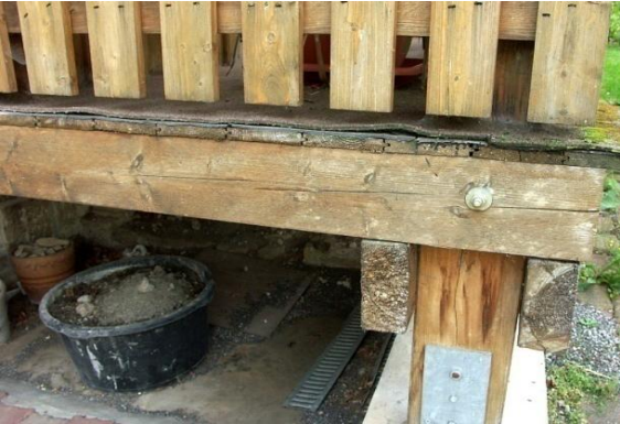
Feuchtflecken und Pilzbefall an Konstruktionshölzern, Verdrehen der Konstruktionshölzer und des Rauspundes
