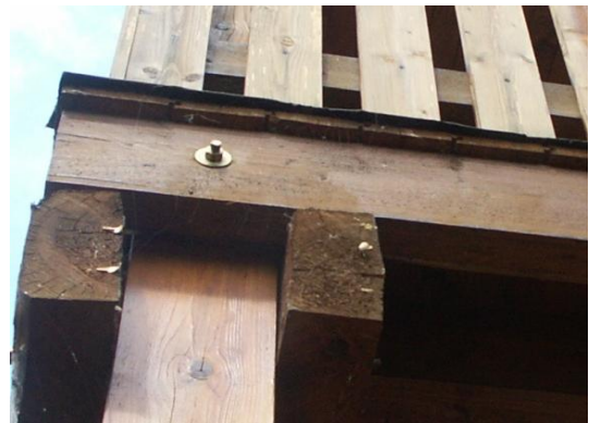
Verdrehen und Aufreißen der Konstruktionshölzer, Balkonansicht von vorn und von der Seite
