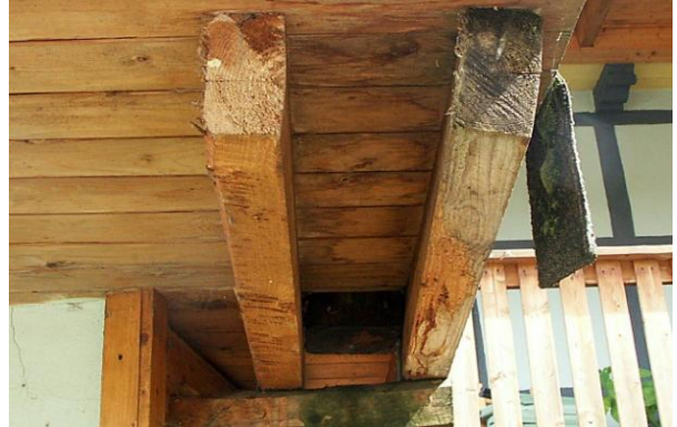
Feuchtflecken und Pilzbefall an Konstruktionshölzern, Verdrehen der Konstruktionshölzer und des Rauspundes
