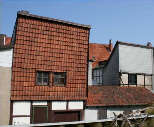
Abb. 67 Wetterschutzbekleidung, hier ausgeführt als Ziegelbehang (DFWZ QLB)
