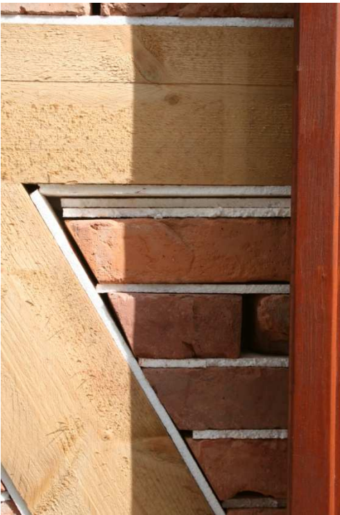
Abb. 94 Mit Ziegelsteinen und Styroporplatten (anstelle der Mörtelfugen) geschlossenes Gefach, Außenansicht
