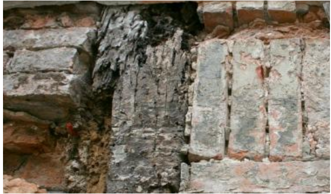
Schwammbefall an den Ziegelsteinen der angrenzenden Gefache, Zerstörung der Steinstruktur
