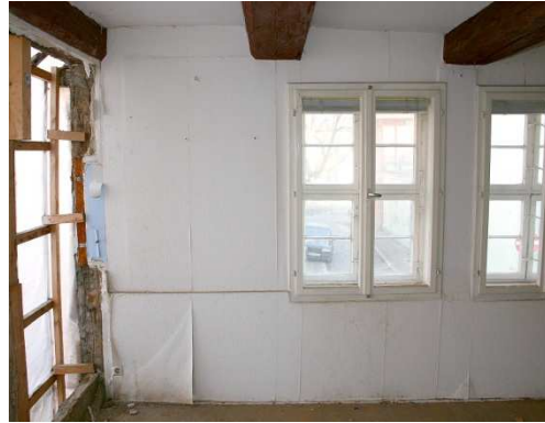
Abb. 84 Innenansicht eines Raumes mit noch vorhandener Vorsatzschale, links im Bild der abgängige Westgiebel (DFWZ QLB)
