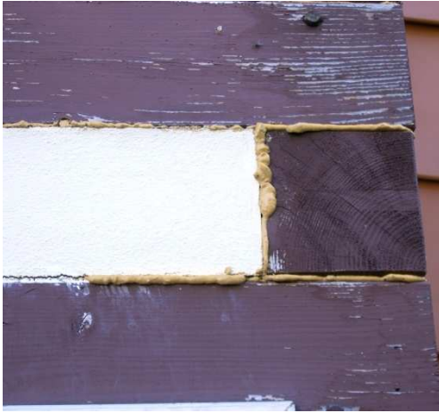
Abb. 39 Bauschaum als Fugenfüllmasse zwischen Ausfachtung und Fachwerk sowie zwischen den Konstruktionshölzern. (DFWZ QLB)
