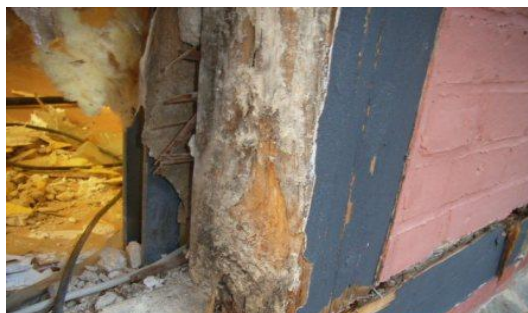
geöffneter Wandaufbau von außen
