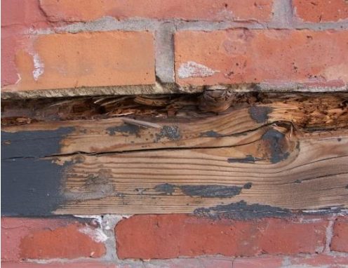
Ablösen des Gefacheanstrichs, hauptsächlich an der Westfassade
