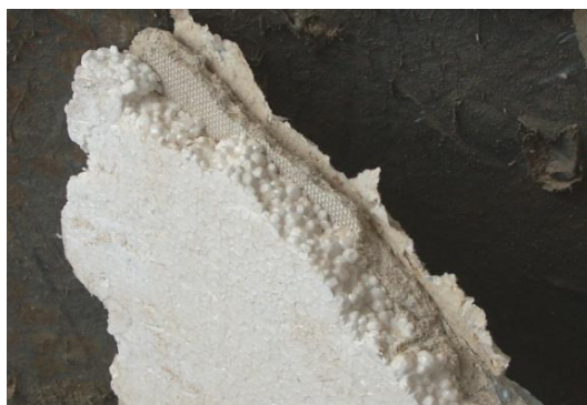
Innendämmsystem: Verbundplatte 1,25 cm Gipskarton auf 1,5 cm Styropor
