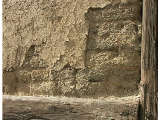
Ausbeulen/Ablösen des Lehmputzes sowie fortschreitendes Auswaschen der Lehmsteinausmauerung
