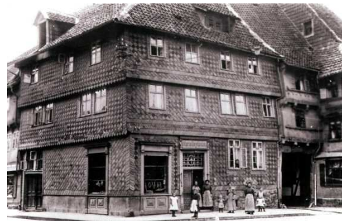
Abb. 69 Schieferbekleidung über alle Stockwerke, Walm-dach um 1905 (Foto: Stadtmuseum Osterwieck)
