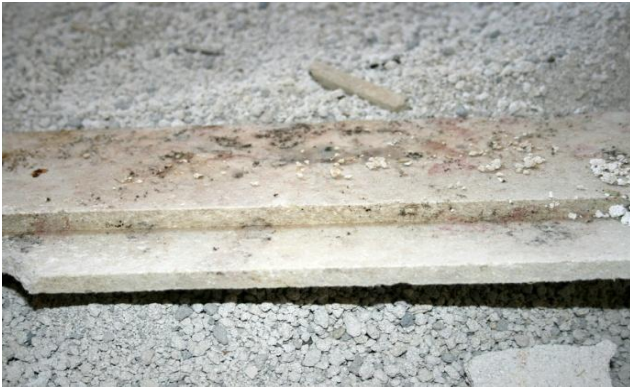
Unterseite eines Gipsfaser-Estrichelementes
