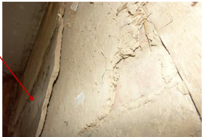
Hohlräume unter der Oberputzschicht, hauptsächlich im oberen Abschnitt der Wandfläche
