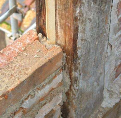
Abb. 50 Ausführungsbeispiel Anschluss Fachwerk-Gefachausmauerung (DFWZ)
