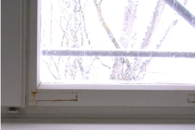
Rostbildung an den Winkelbändern und Beschlägen von innen nach außen
