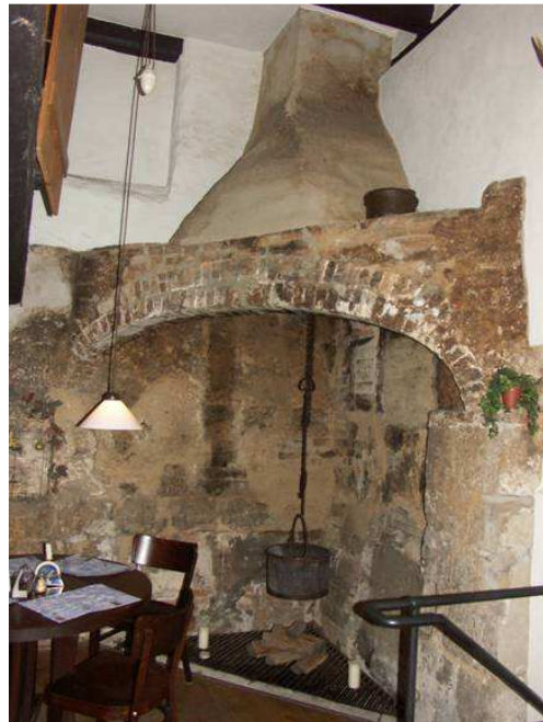
Abb. 9 Feuerstelle in einem Fachwerkbau aus dem 17. Jahrhundert (DFWZ)
