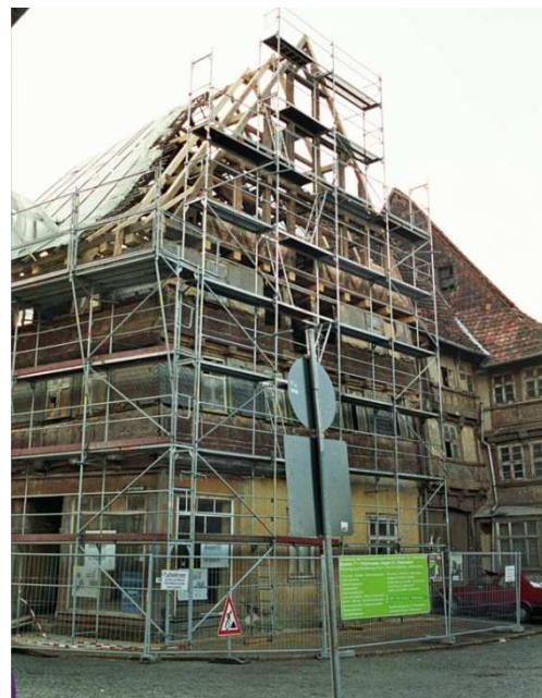
Abb. 71 Umbau des Walmdaches zum fachwerksichtigen Dreiecksgiebel (Foto: privat, Bauherr, 1994)
