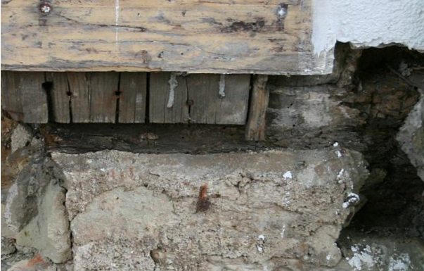
Pilz- und Schwammbefall an den Schwellhölzern im Erdgeschoss (links) und im Obergeschoss (rechts)
