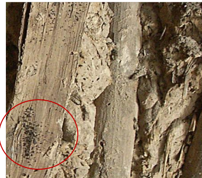
vergrößerte Aufnahme der Schimmelpilze an den Holzstaken
