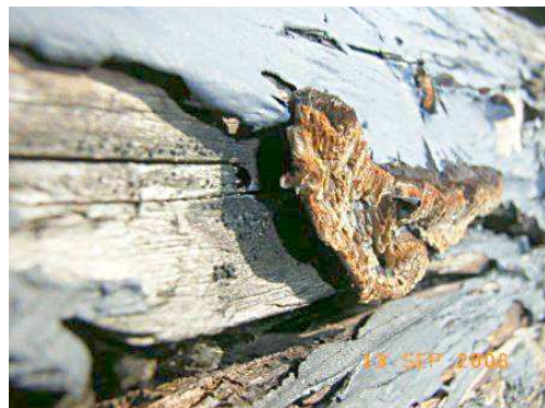
Abb. 23 Fruchtkörper des Zaun- oder Tannenblättlings, hier am Hahnenbalken des Giebeltriecks am zweiten Gebäude (privat, Holzschutzgutachter)
