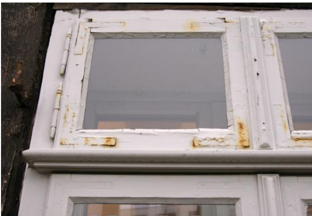
Durchschlagen des Rostes von innen an den Winkelbändern und Stützkloben
