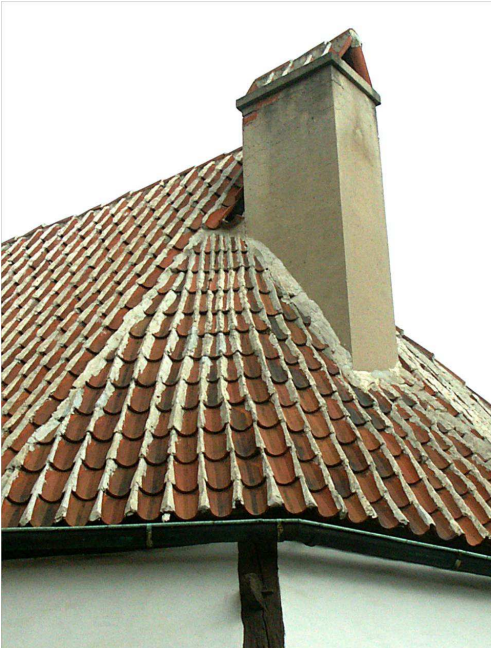
Abb. 7 Ziegeleindeckung mit Kalkleiste: Wordgasse 3 Quedlinburg (DFWZ)
