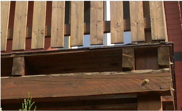
Verdrehen und Aufreißen der Konstruktionshölzer, Balkonansicht von vorn und von der Seite
