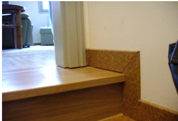
Setzung des Fußbodens mit Abriss der Bodenbeläge von der Randleiste, links im Bad, rechts im Flur
