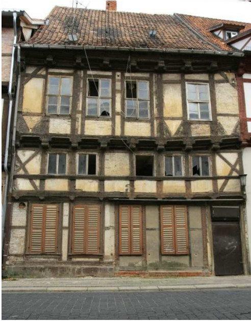
Abb. 13 Beispiel für Fassadenumbauten in verschiedenen Epochen:
