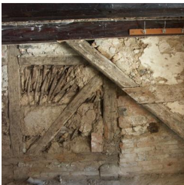
Freigelegtes Gefach giebelseitig, gemeinsame Wand mit Nachbarhaus, Ausfachung aus Lehmstakung
