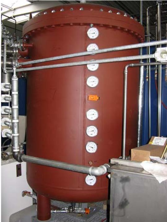
Abbildung 14: Dampfkessel für die Destillationswendel,
