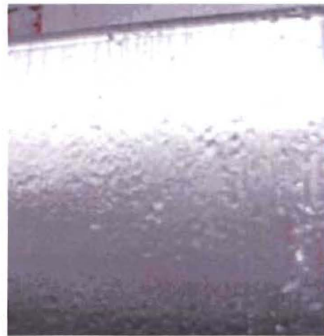
Bild: Oberfläche nach Aufbauschicht
