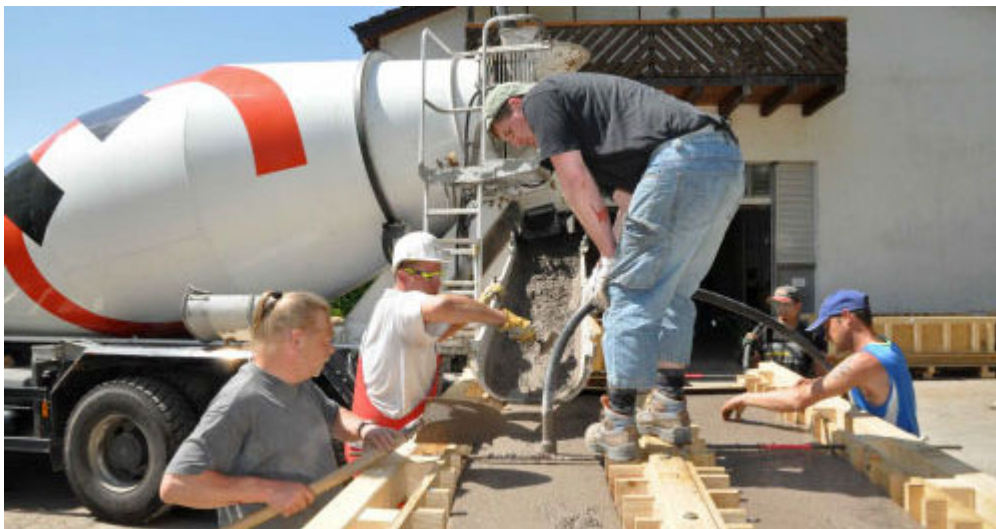
Abb. 12: Giessen der Betonelemente. Photo: Wolfgang Göckel.
