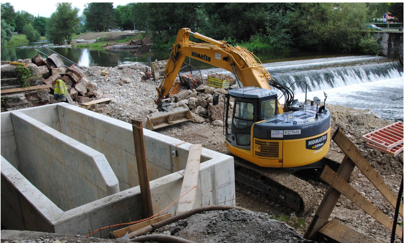
Abb. 8: Bau des Technischen Fischpasses. Photo: Isolde Britz.
