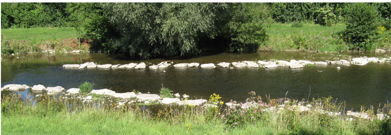
Abb. 18: Strömungstrichter in der Teilstrecke Am Alten Weg. Photo: Daniel Rüetschi.
