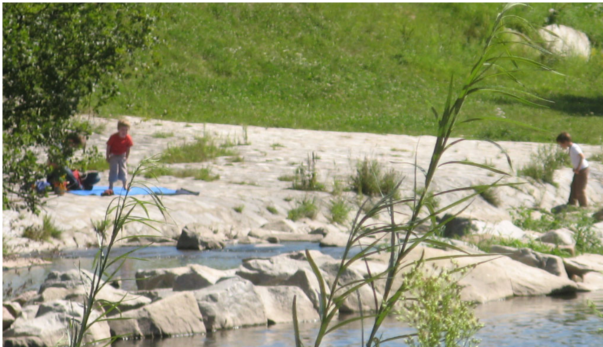
Abb. 10: Der Leitriegel zur Verstärkung der Löckströmung des Umgebungsgewässers bei Niedrigwasser oberhalb der Rauen Rampe wird als Spielplatz genutzt. Photo: Daniel Rüetschi.
