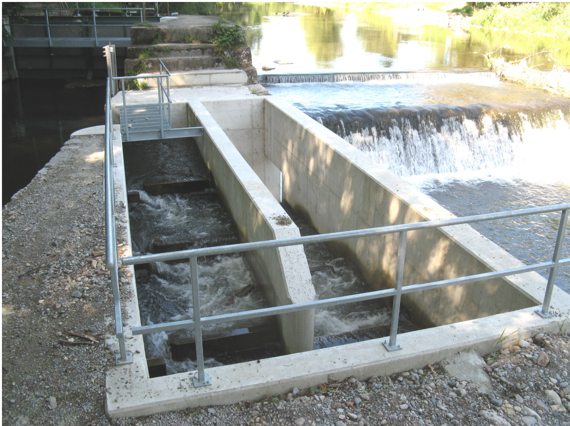
Abb. 9: Technischer Fischpass. Links oben ist die Ausleitung des Weilmühlekanals sichtbar. Photo: Daniel Rüetschi.
