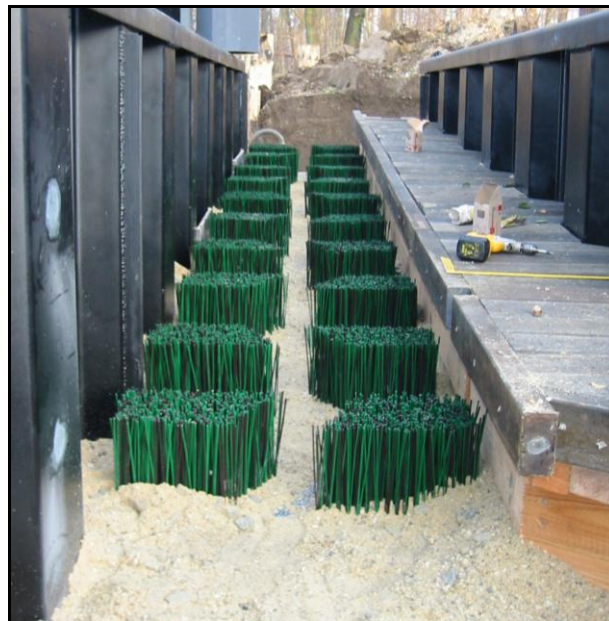
Abbildung 4-3: Fisch-Kanu-Pass am Ende der Einbauphase
