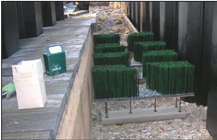
Abbildung 4-2: Fisch-Kanu-Pass in der Einbauphase
