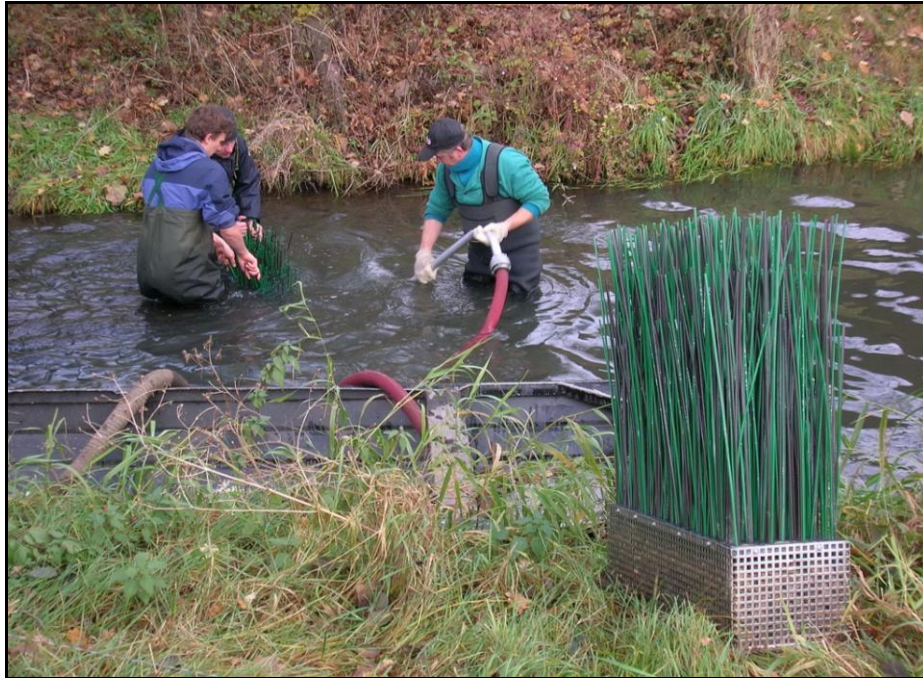
Abbildung 3-6: Einbau mit Spüllanze
