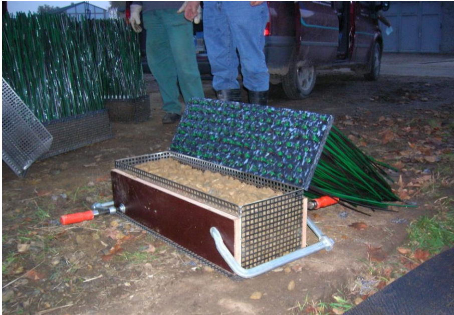
Abbildung 3-2: Montage der Borstenelemente
