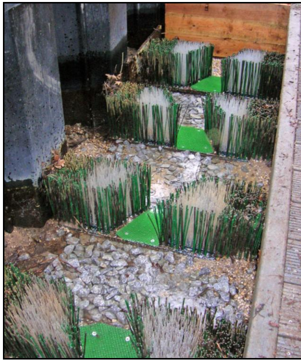
Abbildung 4-6: Umgerüsteter Fisch-Kanu-Pass mit weichen Borsten und Makrozoobenthos-Matten
