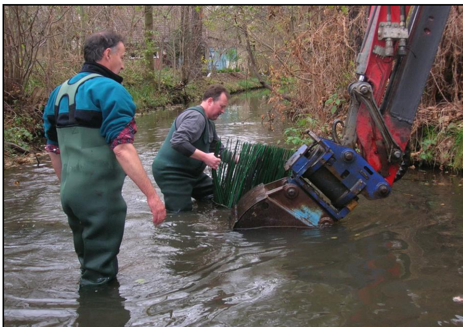
Abbildung 3-5: Einbau mit Schreitbagger
