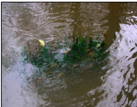
Abbildung 3-7: Kleine Spree mit eingebauten Borstenelementen
