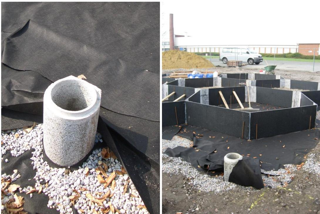
Abbildung 52: Konstruktive Versuchsvorbereitungen (links: Pumpenschacht mit einem Filter aus gut durchlässigem haufwerksporigen Beton am tiefsten Punkt der Drainageschicht, rechts: Trennung der Messfelder mittels PVC-Platten).
