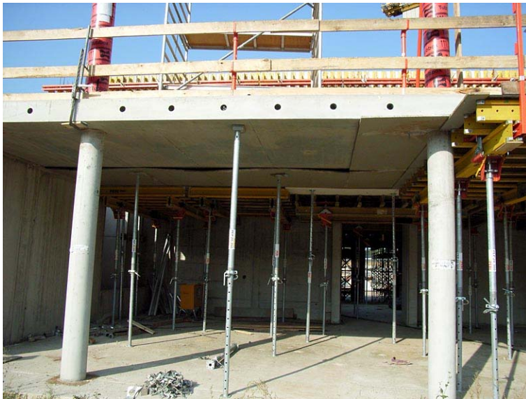
Abbildung 42: Stahlbetonflachdecken Herwig-Blankertz-Berufskolleg mit Zuluft-Rohren (rechts)
