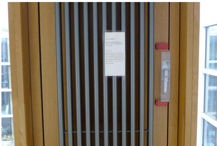
Abbildung 18: Rauchentlastungsflügel Max-Born-Berufskolleg
