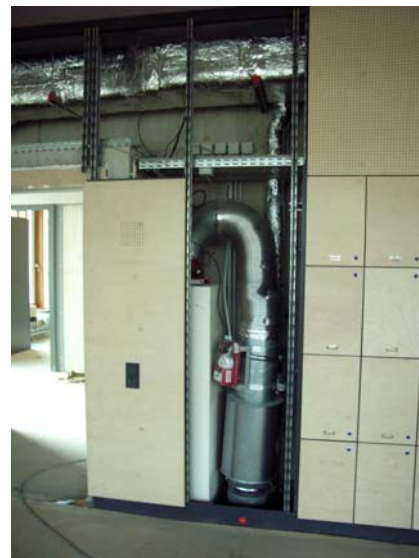
Abbildung 25: Kollision Schalldämpfer mit Ausbau Lehrerzimmer Herwig-Blankertz-Berufskolleg Abbildung 26: Anpassung Lage Schalldämpfer an Ausbau (rechts)
