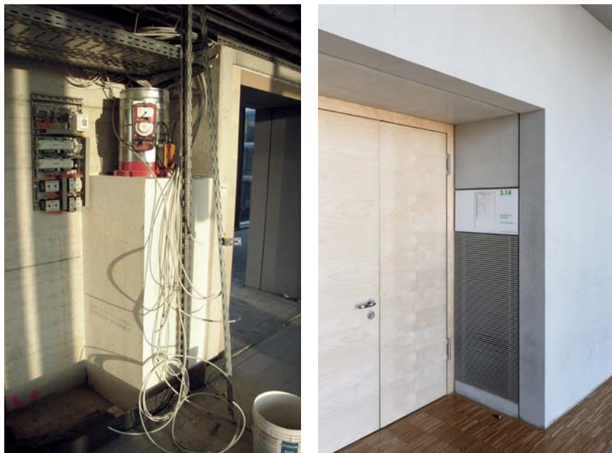
Abbildung 15: Überströmöffnung mit Lamellengitter und Wechselschild flurseitig (rechts)
