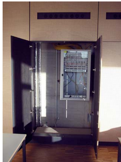
Abbildung 20: eingehängtes Wandpaneel, z.B. vor Steuereinheiten und BSK (rechts)
