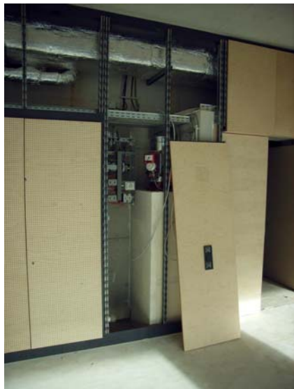
Abbildung 20: eingehängtes Wandpaneel, z.B. vor Steuereinheiten und BSK (rechts)
