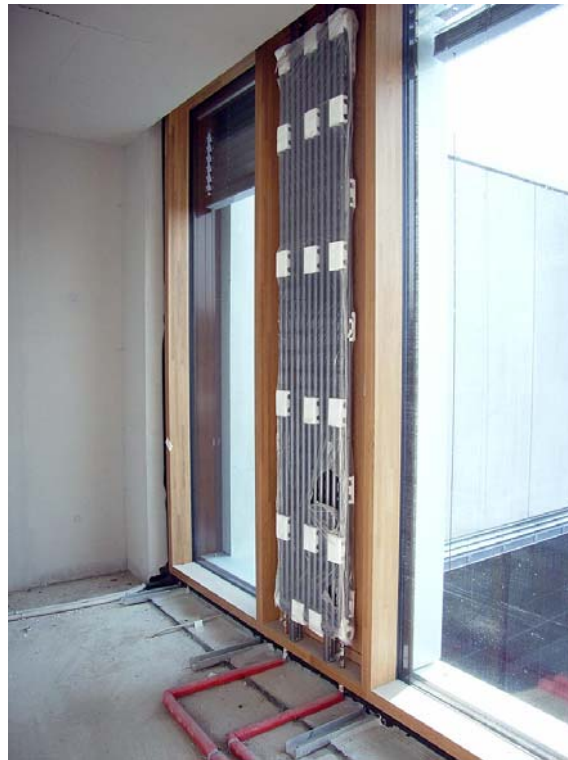
Abbildung 33: Integration Röhrenradiator in die elementierte Holzfassade
