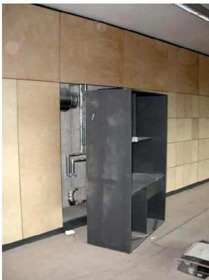
Abbildung 25: Kollision Schalldämpfer mit Ausbau Lehrerzimmer Herwig-Blankertz-Berufskolleg Abbildung 26: Anpassung Lage Schalldämpfer an Ausbau (rechts)
