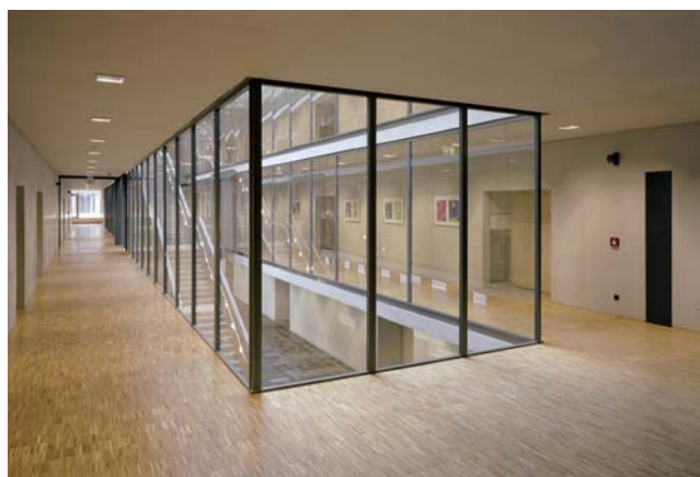
Abbildung 14: Brandschutzverglasung Halle Herwig-Blankertz-Berufskolleg
