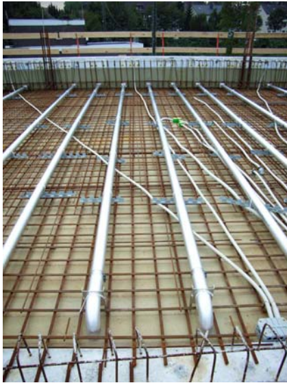
Abbildung 40: Rohdecken-Einlegearbeiten Zuluft-Rohre (links)
