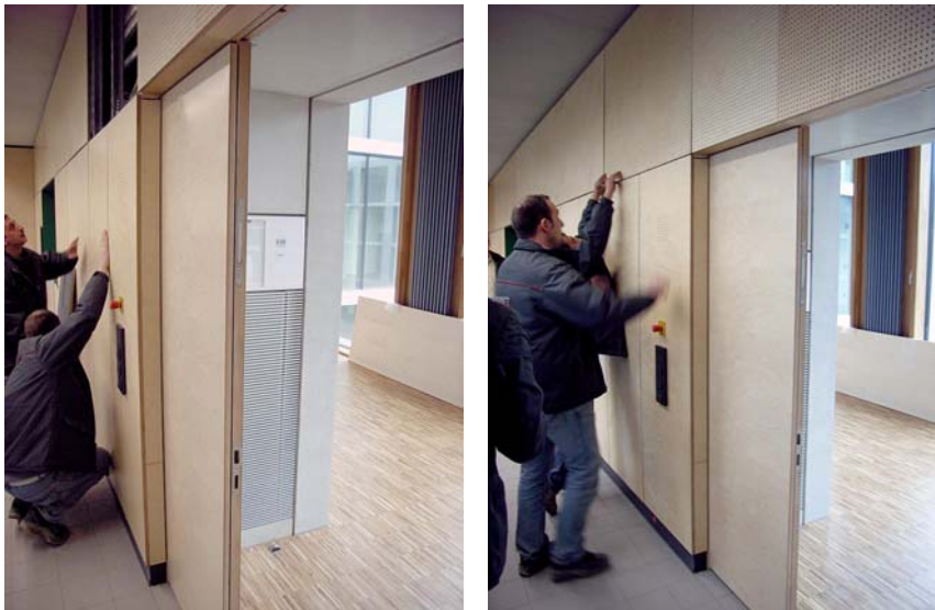
Abbildung 45: Test Handhabung Revisionsöffnungen Wandbekleidung durch den Betreiber
