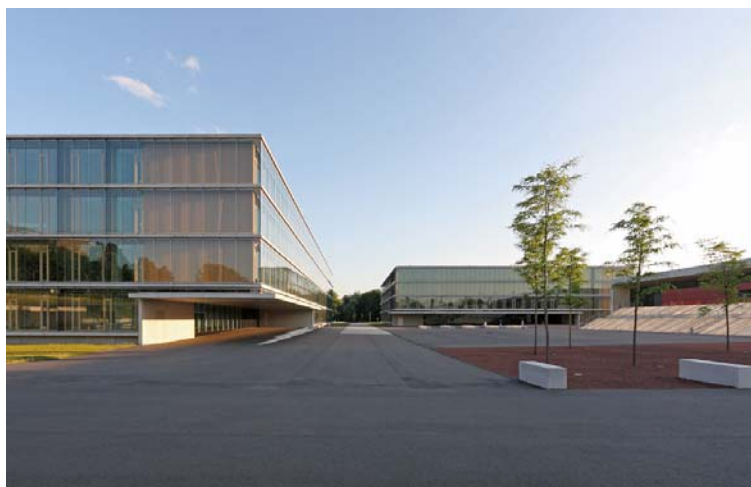
Abbildung 2: Ansicht Campus Vest von Nord
