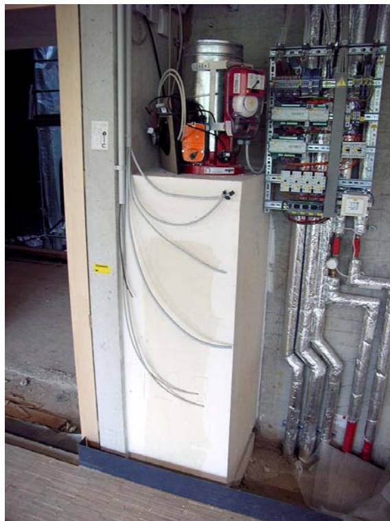
Abbildung 8: Raumsteuerung und Überströmöffnung mit Schalldämpfer und BSK
