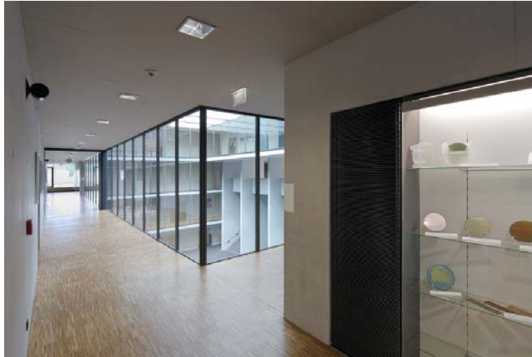
Abbildung 36: Brandschutztür mit Feststellanlage Galerie Halle Max-Born-Berufskolleg
