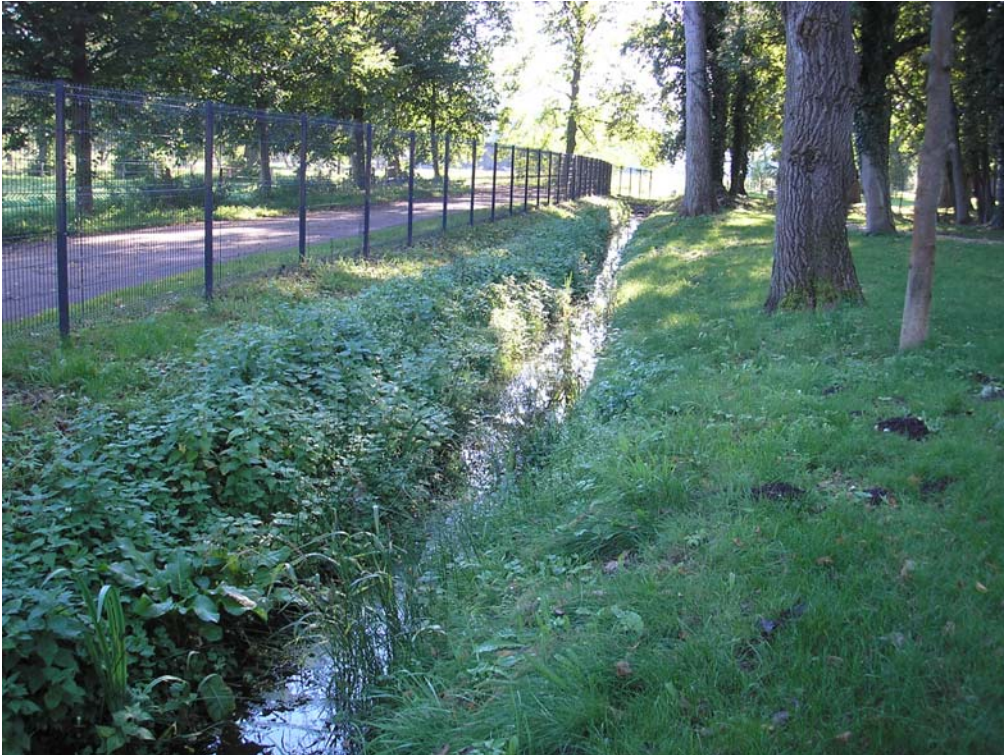
Abb. 5: Graben zwischen den Teichen nach der Sanierung (September 2010)
