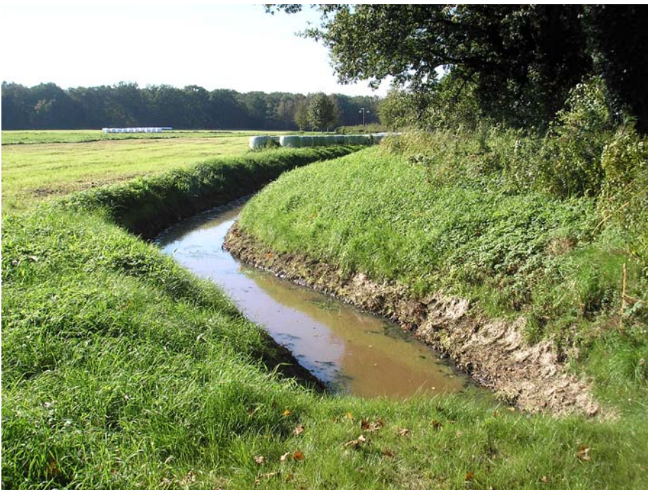
Abb. 20: Graben zwischen Teich am Falkenhain und Lake nach der Sanierung
