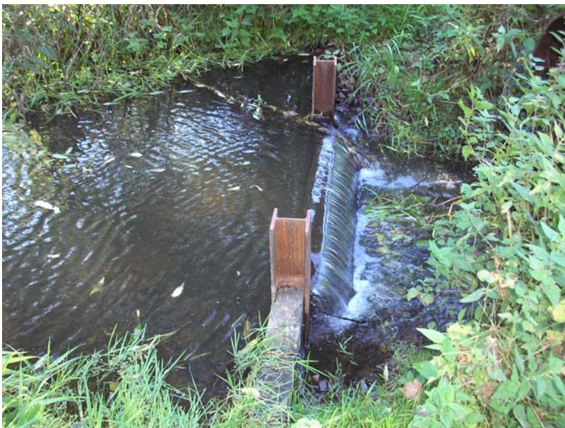
Abb. 3: Errichtetes Staubauwerk zu Wasserzufuhr von der Sude
