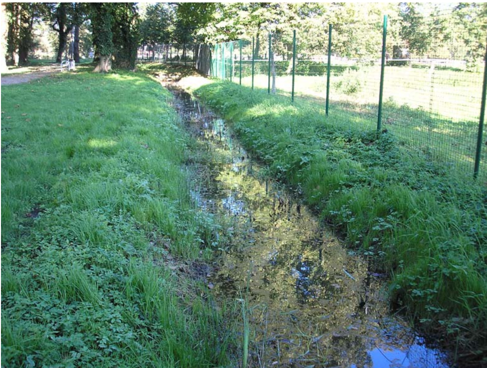
Abb. 6: Graben zwischen den Teichen nach der Sanierung (September 2010)
