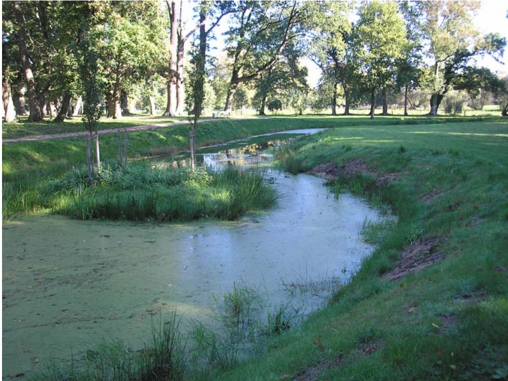
Abb. 13: Bereich Rousseau-Insel nach der Sanierung (September 2010)
