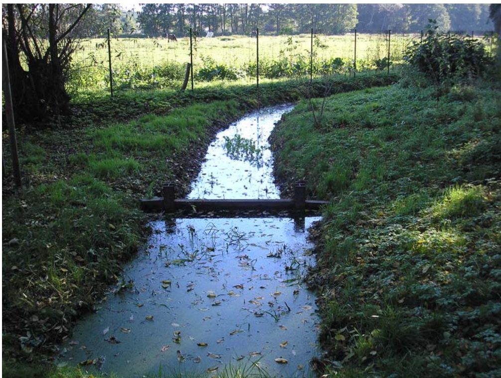
Abb. 14: Wasserstandsregulierung nach Teich am Falkenhain (September 2010)
