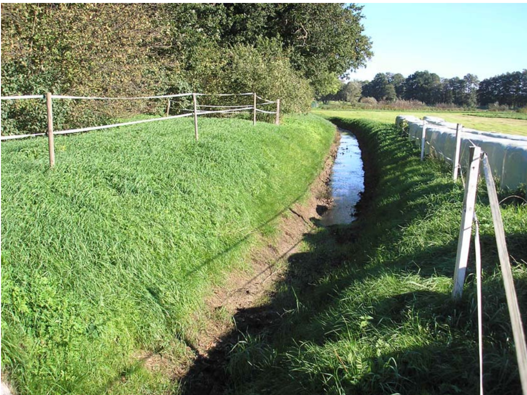
Abb. 16: Auslauf Regenwasser in Grabensystem nach der Sanierung (September 2010)
