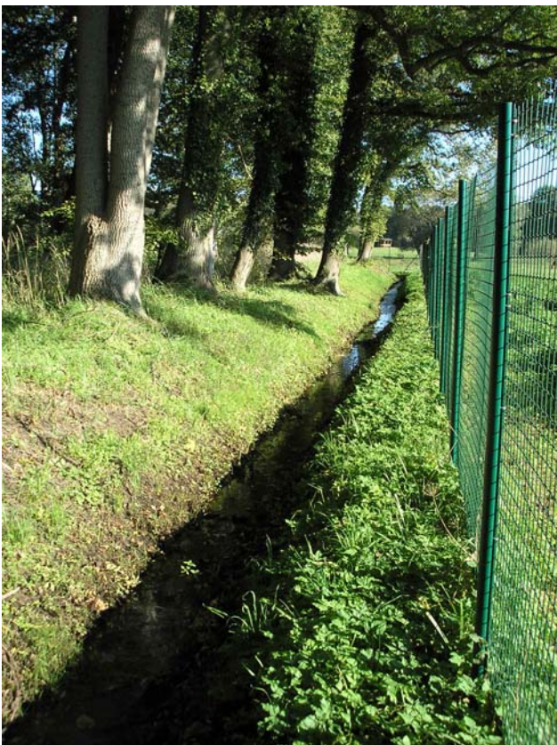
Abb. 18: Graben zwischen Teich am Falkenhain und Lake nach der Sanierung (September 2010)
