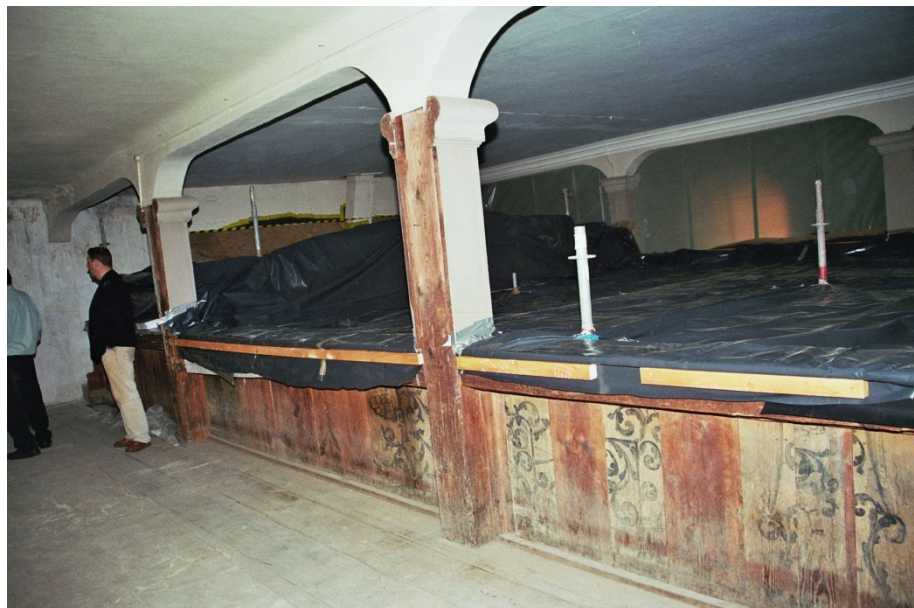
10/2007 : Einhausung der Emporen zum Schutz historischer Bausubstanz
