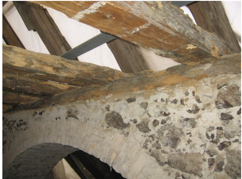
Erforderlicher Rückbau aller Bekleidungen sowie aller Holzbauteile in Bereichen mit Hauschwammbefall
