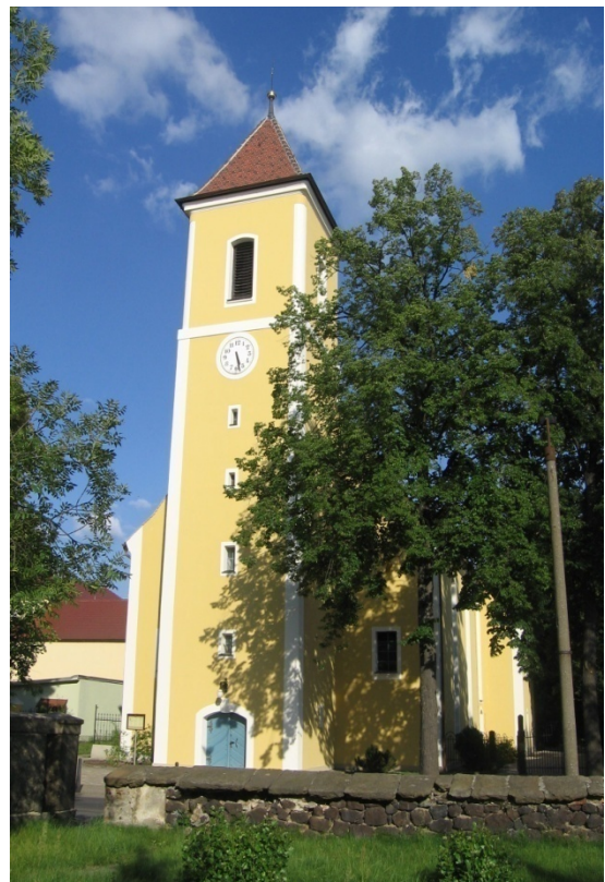
07/2008 : Fassadensanierung unter aufopferungsvoller Hilfe örtlicher Firmen
