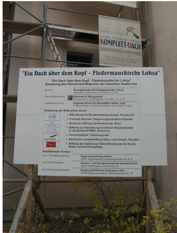
1.10.2007 : Offizieller Baubeginn vor der Kirche aufgestellte Bautafel mit Benennung der Beteiligten
