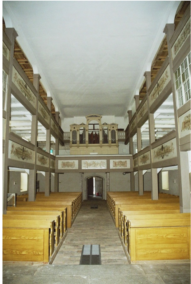
05/2008 : Innenansicht mit wiederhergestellter Decke einschl. Stuckprofilierungen
