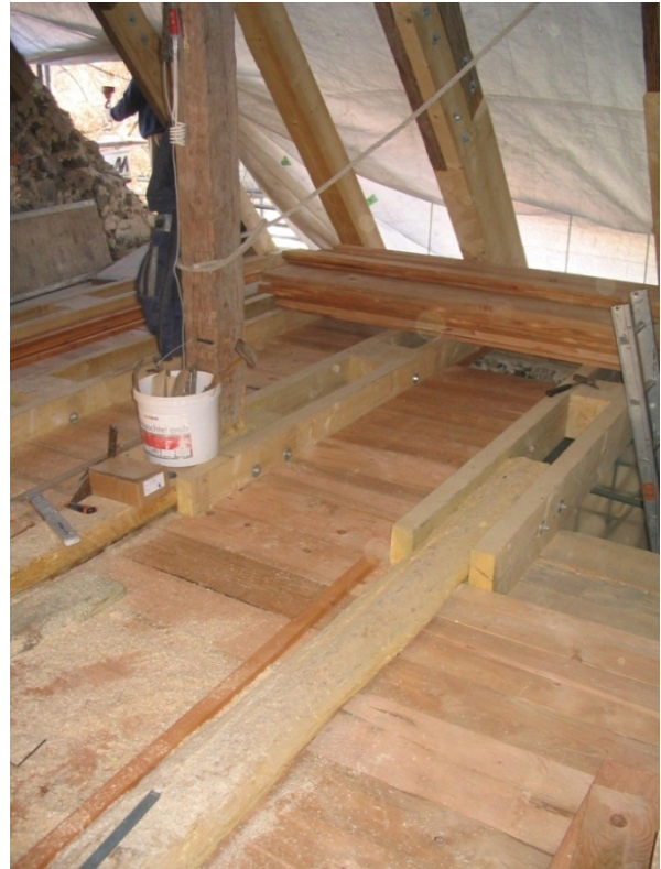
Angeschuhte bzw. bebeilte Deckenbalken mit neuem Einschub entsprechend historischer Konstruktion
