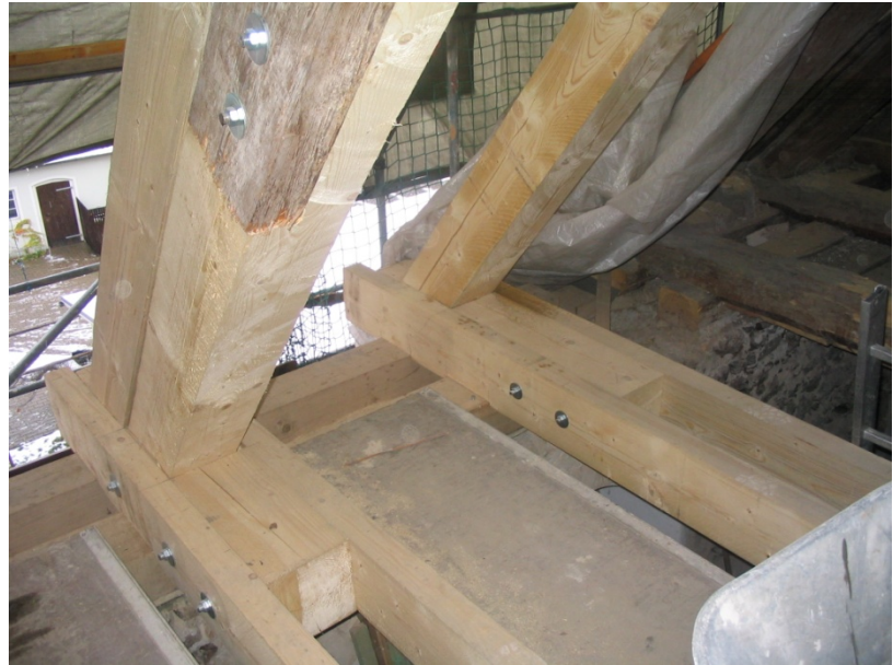
Neue doppelte Eichenschwelle mit angeschuhtem Bindersparren bzw. Sparren eingebaute Holzbauteile vorgetrocknet, nicht imprägniert
