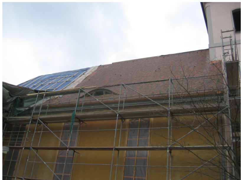
Winter 2007/2008 : abschnittsweise Fertigstellung der Dacheindeckung links noch Schutzdachkonstruktion im Traufbereich
