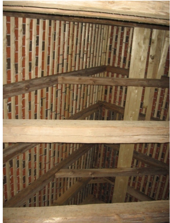
Ansicht Laufsteg Hahnebalke mit eingebauter Altlattung im Bereich des Nistquartiers der Fledermäuse zwischen den Bauachsen 15 bis 21 (untere Bildhälfte); eingebaute Neulattung getrocknet, nicht imprägniert
