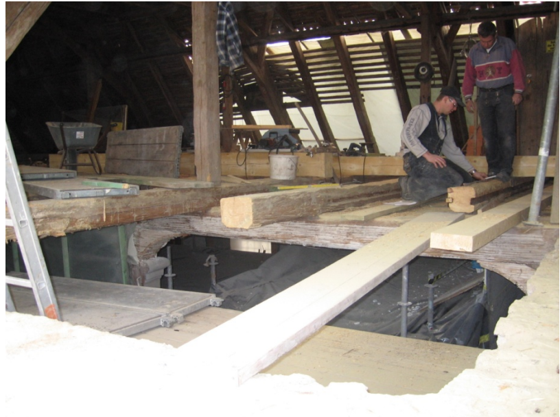
Rückschnitt des geschädigten Holzes einschl. Sicherheitszone
