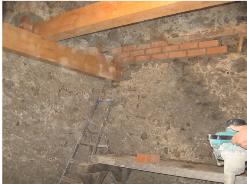
Sanierungsarbeiten Turmbereich mit Hausschwammbefall
