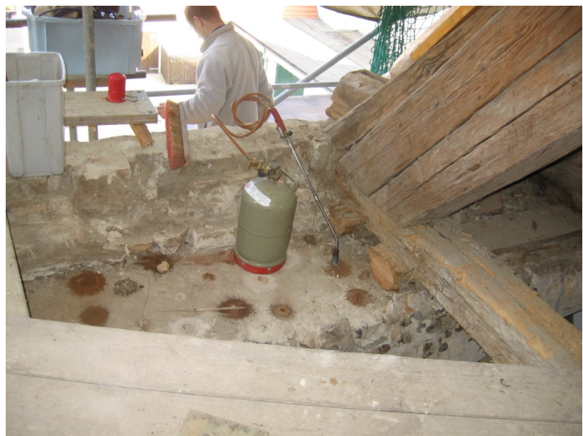
Schwammsanierung des befallenen Mauerwerks durch Verpressung
