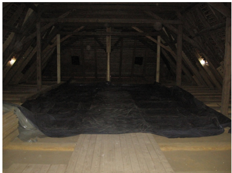
Ansicht Laufsteg Dachboden in Richtung Ost mit Exkrementenauffangung aus PE-Folie auf Dielung sowie abgedunkelten Dachfenstern
