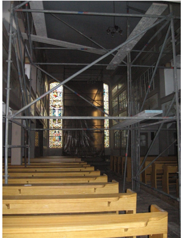
Staubdichte Schutzeinhausung der barocken Kanzel
