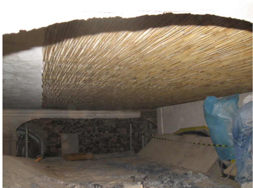
Rekonstruktion der Kirchendecke über der Orgel mit neuem Schilfgewebe
