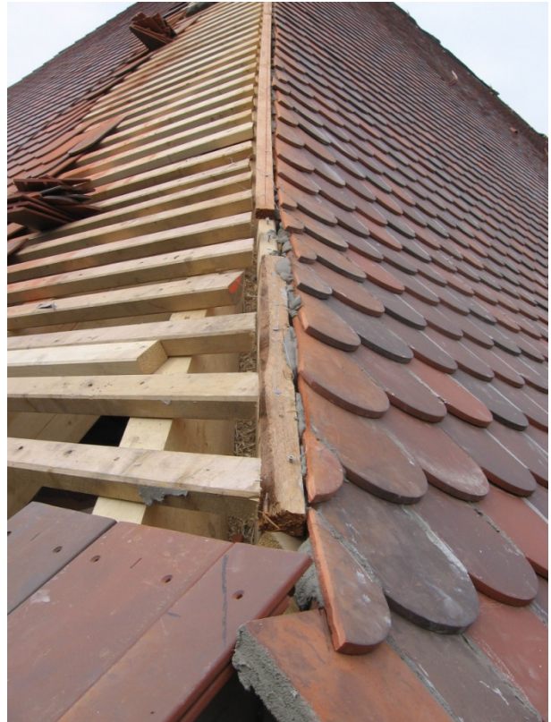
Gratbereich mit gedrahteter gemörtelter Biberdeckung
