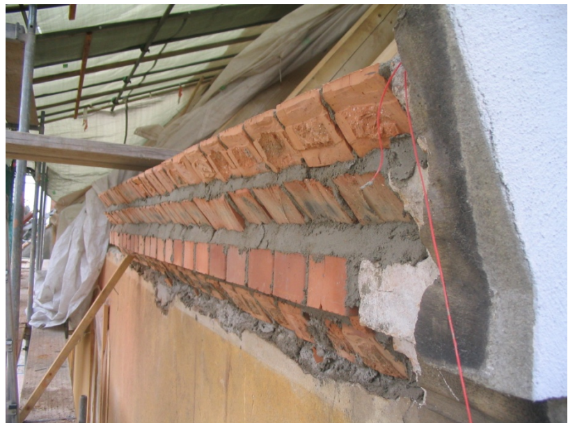
neu aufgemauertes Traufgesims mit historischer Profilierung
