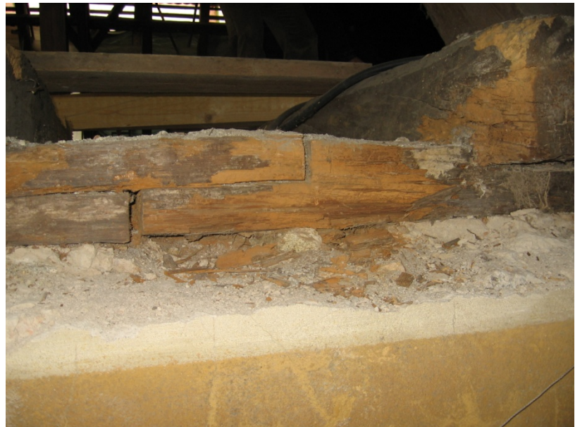
11/ 2007 bis 02/2007 : abschnittsweises Freilegen des gesamten Traufbereiches aufgrund Hauschwammbefall
