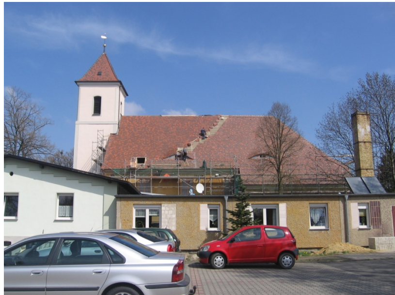
Frühjahr 2008 : Neue gemörtelte Bibereindeckung Süd mit Ochsenaugen
