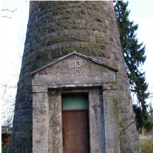
Eingang alter Wasserturm
