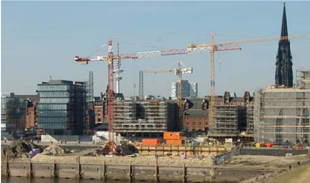
Abb. 10.1: Baustelle Hafencity, Grundwasserhaltung im Tidebereich des Hamburger Hafens
