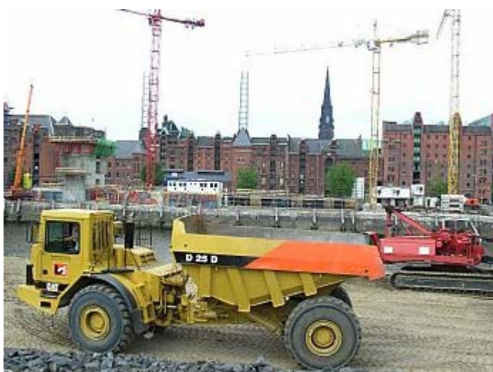
Abb. 10.2: Baustelle Hamburger Hafencity vor Beginn der Tiefbaumaßnahmen
