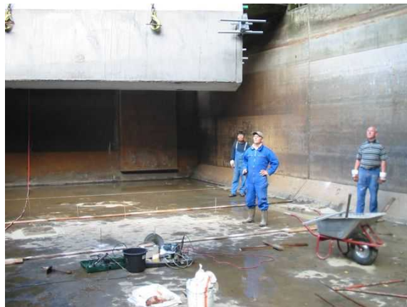
II. Ein WasserWand-Element wird herabgelassen.
