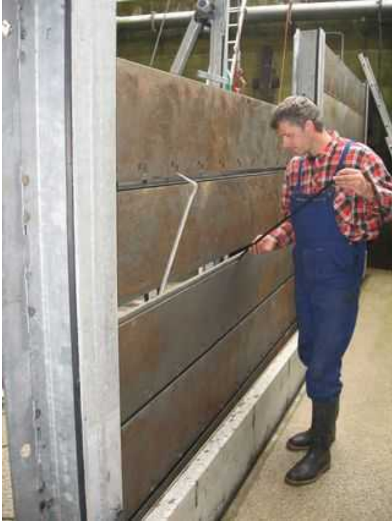
Abbildung 36: Dichtungswechsel an den Dammwinkeln
