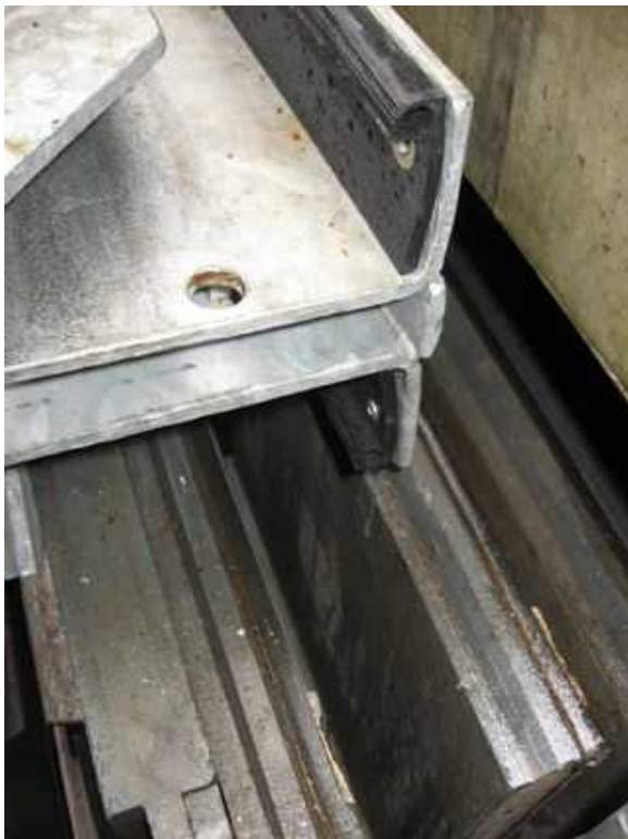
Abbildung 26: Dichtung am Pfosten
