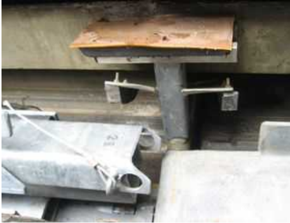
Abbildung 38: Dichtungswechsel des Dichtkissens
