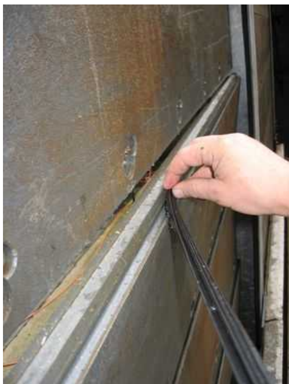
Abbildung 22: Das Dichtgummi wird in die Dammwinkel eingesetzt
