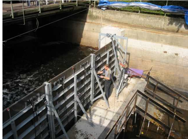
II. das Testbecken von der Trockenseite
