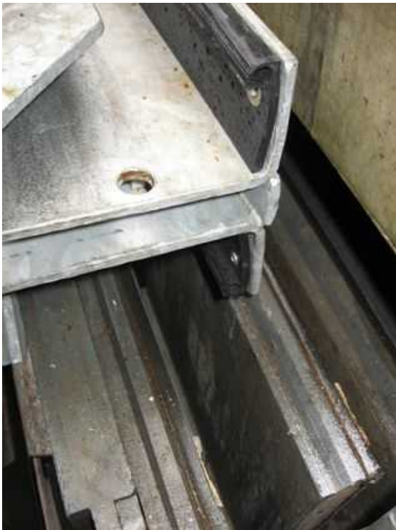
Abbildung 37: Dichtungswechsel beim Pfosten
