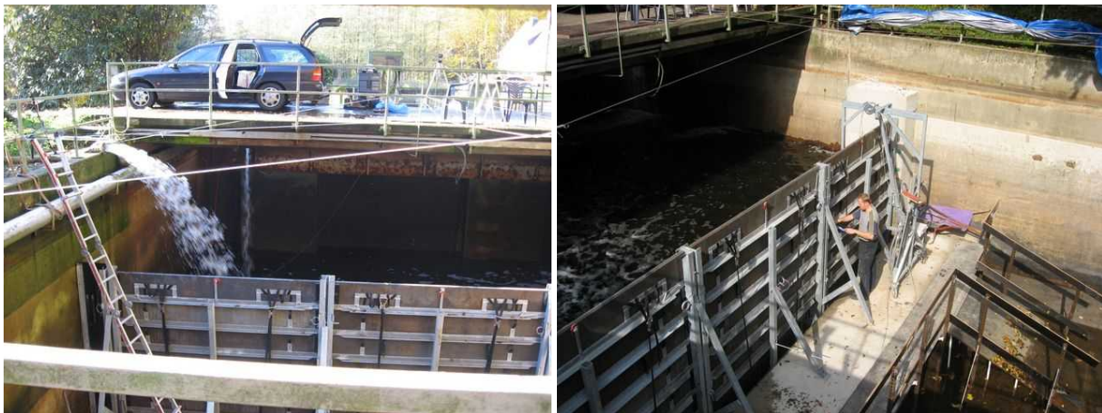
I: Wasser wird in den Testbereich eingefüllt.
