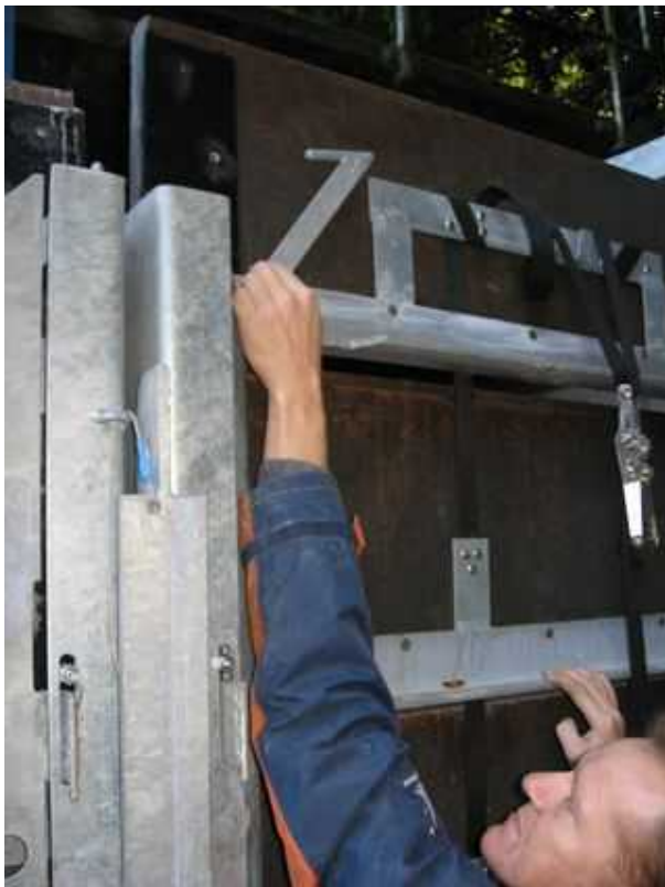
Abbildung 35: WasserWand wird für eine Wartung aufgehängt
