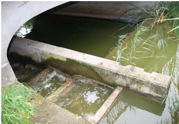
Ausgangssituation: Wehranlage in Döbbersen mit nicht funktionsfähiger Fischaufstiegsanlage und einem 2005 provisorisch errichteten Ottersteg
