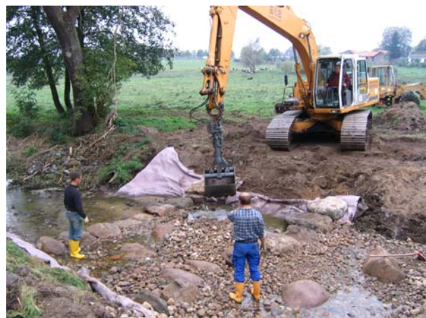
Bau der Fischaufstiegsanlage
