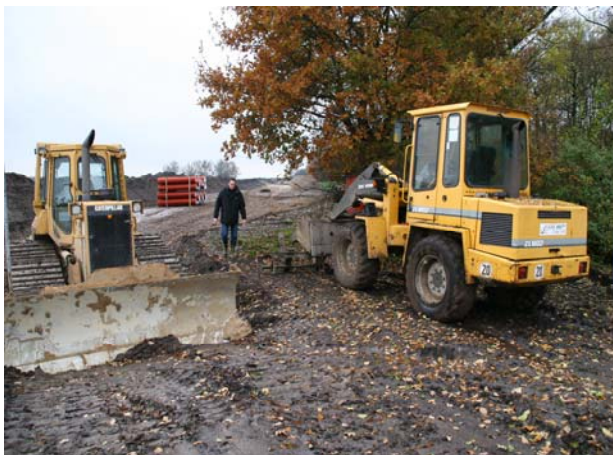
Vorbereitungen für die Verlegung der Drainage- rohre
