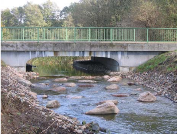
Fischaufstiegsanlage nach der Fertigstellung
