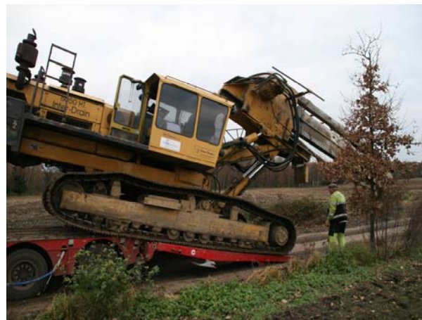
Abladung der Fräse für die Verlegung der Rohre
