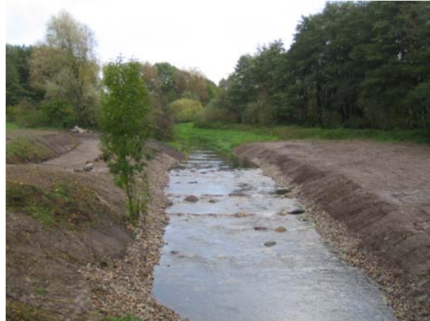
Die Schilde in Karft nach Fertigstellung der Fisch- und Evertebratenaufstiegsanlage
