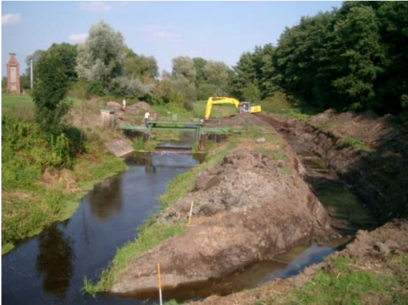
Bau einer Umlaufrinne für die Beseitigung des Wehres
