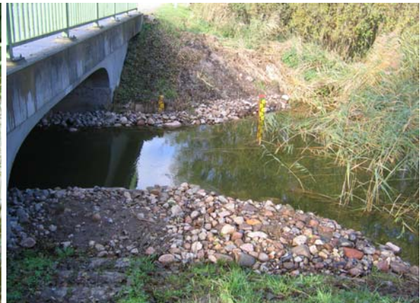
Schilde nach Beseitigung der Wehranlage. Für den Otter wurde eine Passiermöglichkeit aus Natursteinen an beiden Uferseiten geschaffen
