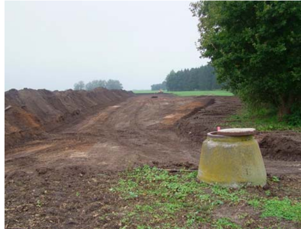
Die Trasse für die Verlegung des Bypasses, links der gesicherte Mutterboden
