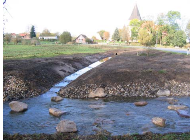
Öffnung eines verrohrten Grabens, der im Bereich der Fischaufstiegsanlage in die Schilde mündet
