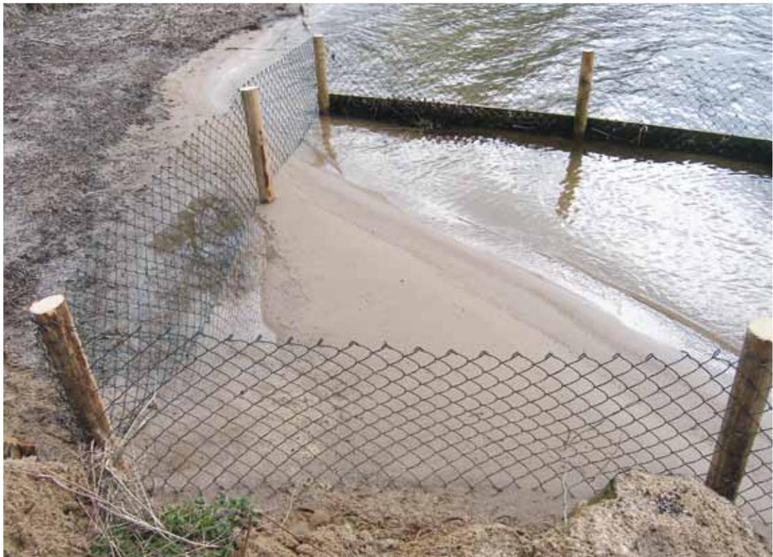
Abbildung 33: Sandaufschüttung nach dem Entfernen einer Spundwand am Großen Plöner See.
