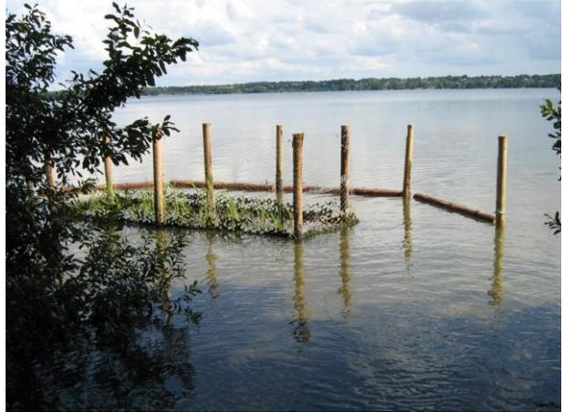
Abb. 9: Schwimmender Wellenbrecher am Großen Plöner See
